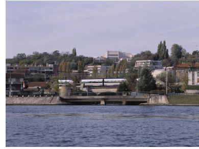
Le nouveau pont construit en 1972. Phot. Philippe Ayrault IVR11_20029101632XA
