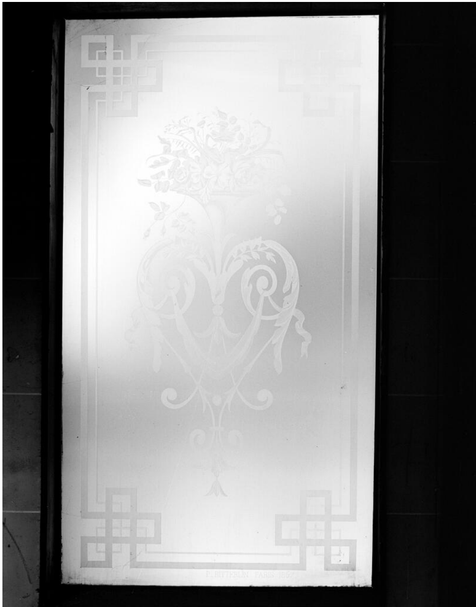
Verrière du palier de l'escalier au 1er étage.
