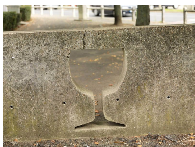
Détail d'un mur de béton figurant un verre au 19 rue de la Grande Borne. Phot. Stéphane Asseline IVR11_20129100032NUC4A
