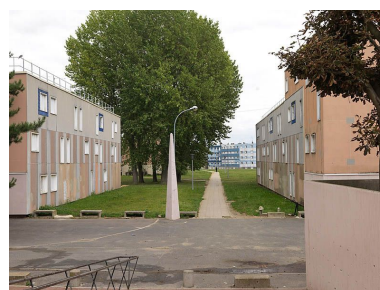
Vue entre les bâtiments de la place de l'Eglise et la place du Miroir. Phot. Stéphane Asseline IVR11_20129100093NUC4A
