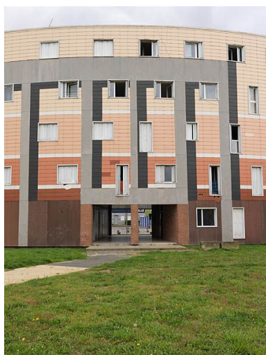
Quartier de l'Astrolabe. Phot. Stéphane Asseline IVR11_20129100058NUC4A
