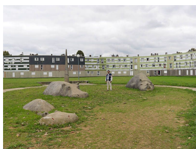
Vue intérieur du quartier du Marigot. Phot. Stéphane Asseline IVR11_20129100064NUC4A
