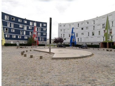
Place de l'Astrolabe. Phot. Stéphane Asseline IVR11_20129100056NUC4A
