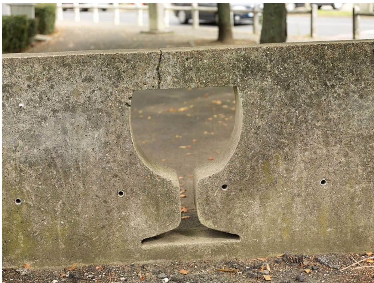
Détail d'un mur de béton figurant un verre au 19 rue de la Grande Borne.
