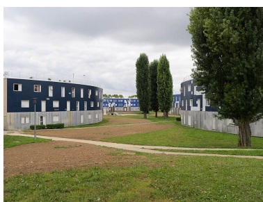
Vue intérieur du quartier du Pont. Phot. Stéphane Asseline IVR11_20129100065NUC4A
