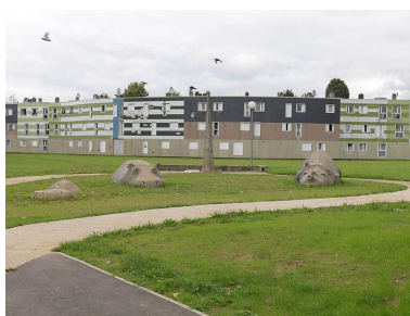
Vue intérieur du quartier du Marigot. Phot. Stéphane Asseline IVR11_20129100059NUC4A
