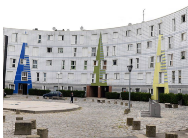
Place de l'Astrolabe. Phot. Stéphane Asseline IVR11_20129100055NUC4A
