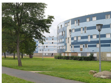
Vue du quartier des Balances. Phot. Stéphane Asseline IVR11_20129100019NUC4A
