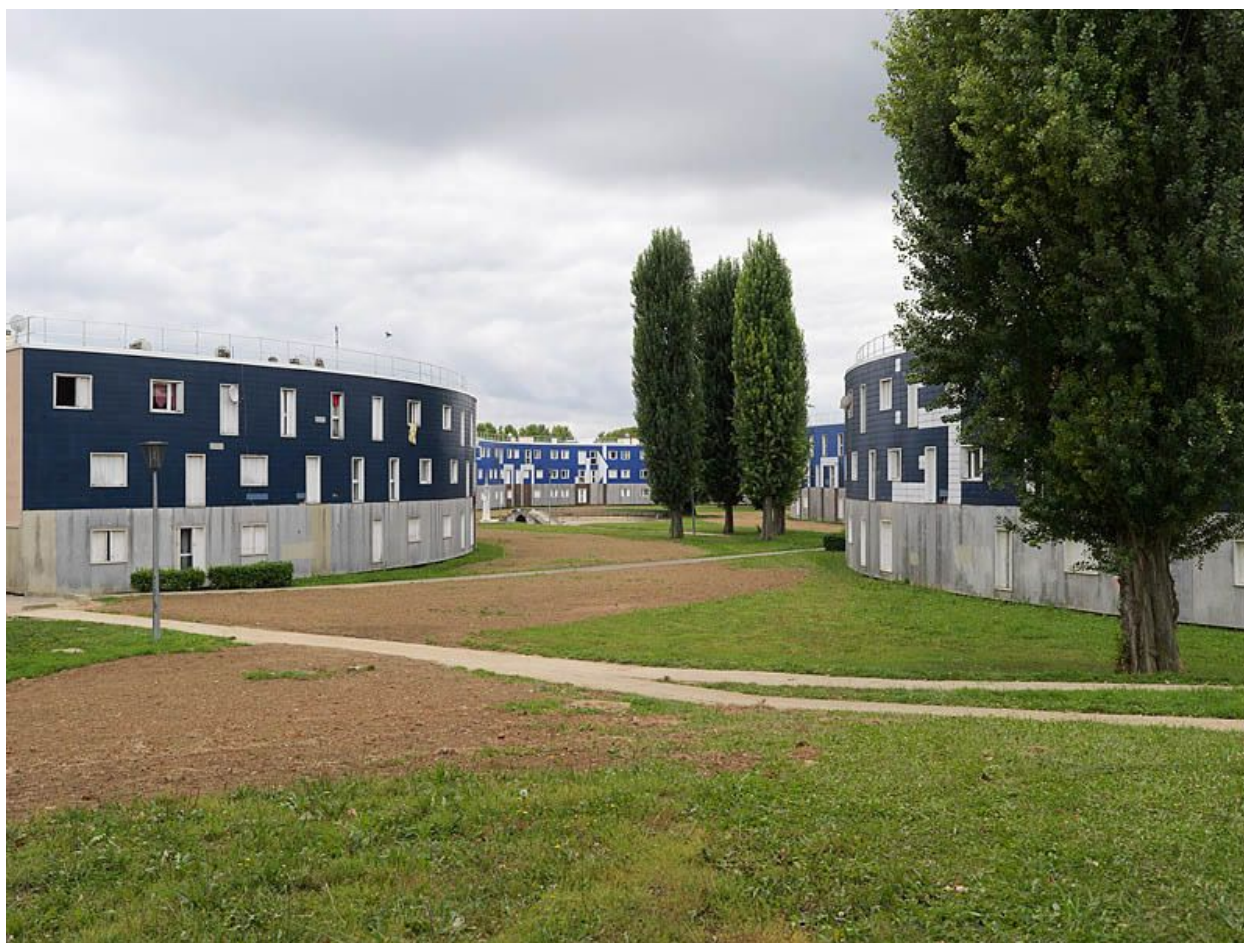
Vue intérieur du quartier du Pont.
