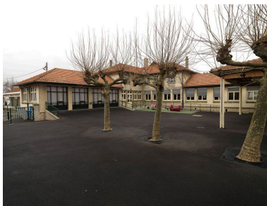
Les agrandissements de l'école maternelle. Phot. Laurent Kruszyk IVR11_20087800106NUC4A
