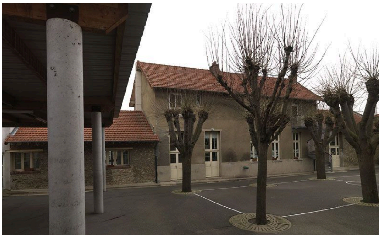
La façade postérieure de l'école des garçons. Le bâtiment se trouve entre les deux cours de récréation.
