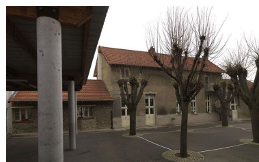
La façade postérieure de l'école des garçons. Le bâtiment se trouve entre les deux cours de récréation. Phot. Laurent Kruszyk IVR11_20087800102NUC4A
