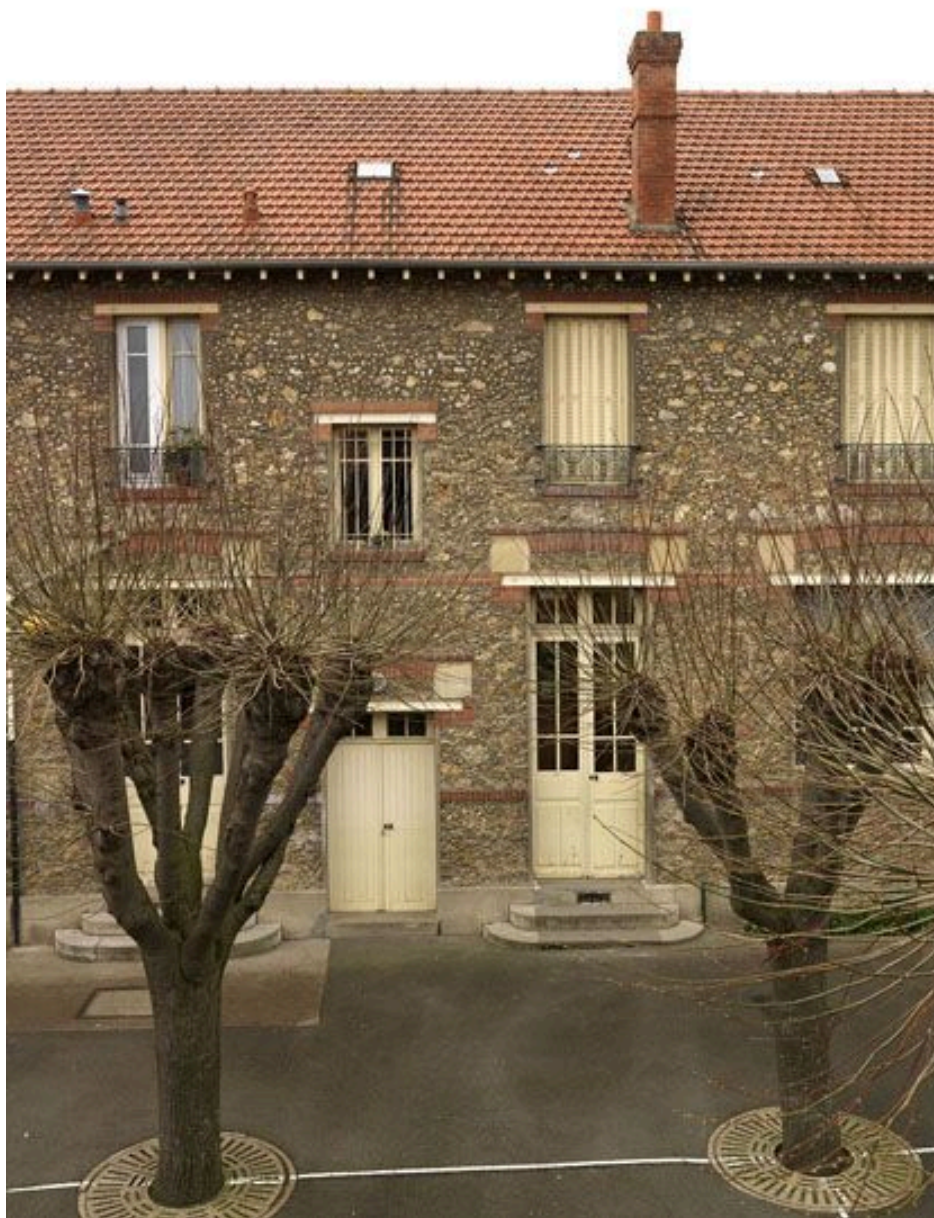
L'école des filles: façade antérieure la partie centrale.
