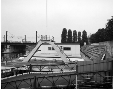
Vue du bassin utilisé comme bureaux. Piscine Phot. Jean-Bernard Vialles IVR11_19899200413XS
