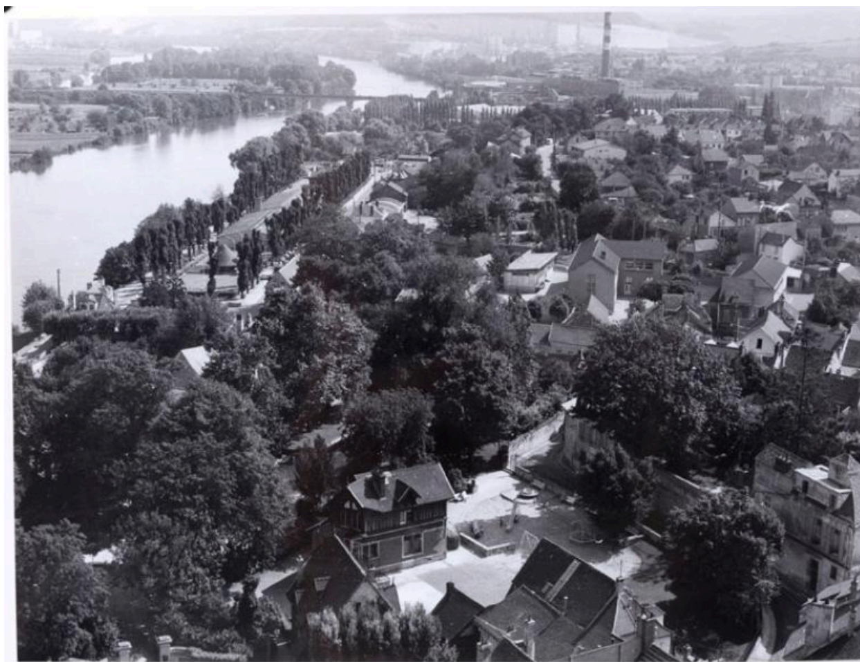
Vue du square du château. (Fonds CREDOP).
