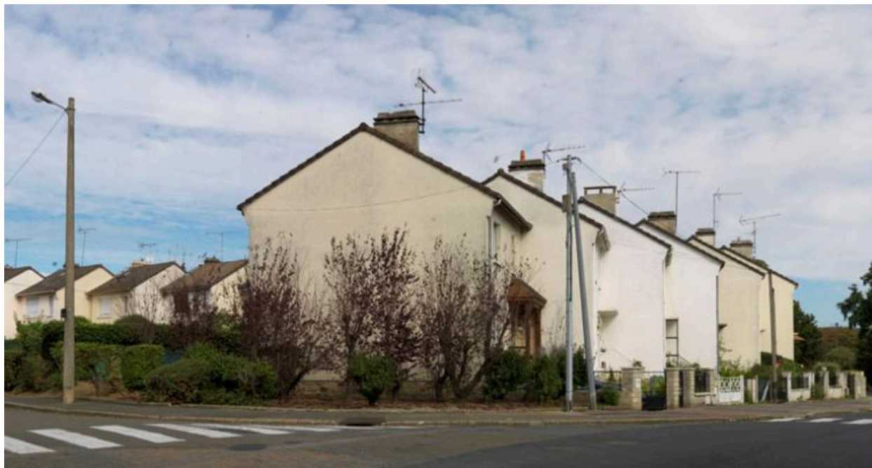
Vue d'ensemble du groupe des Cordeliers depuis la rue des Cordeliers.
