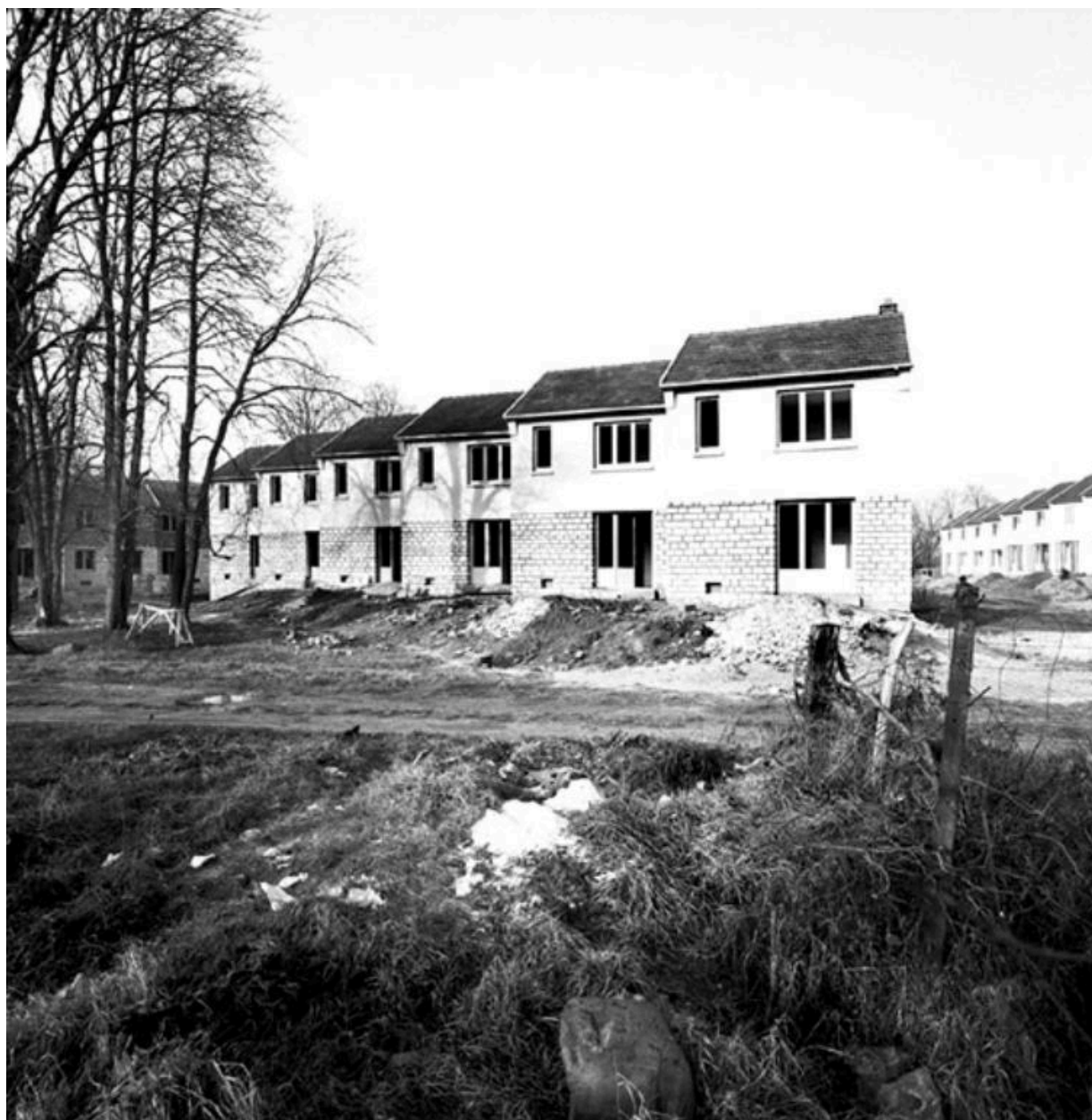
La résidence en construction. (Fonds Bertin).
