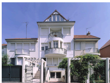
Vue d'ensemble. Phot. Stéphane Asseline IVR11_20049400136VA
