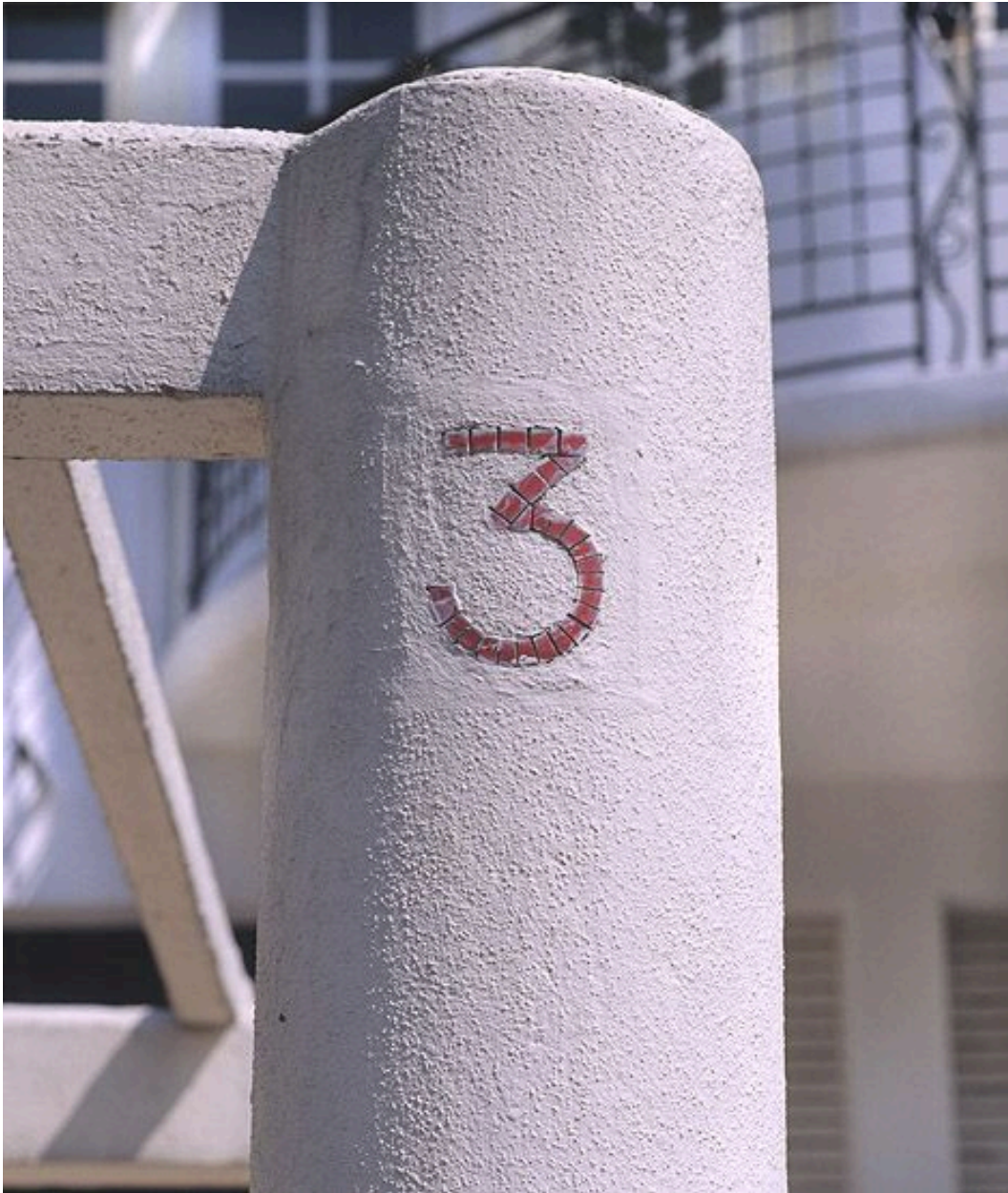
Détail du numéro en céramique incrustée dans la maçonnerie de la cloture.
