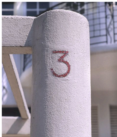
Détail du numéro en céramique incrustée dans la maçonnerie de la cloture. Phot. Stéphane Asseline IVR11_20049400141XA
