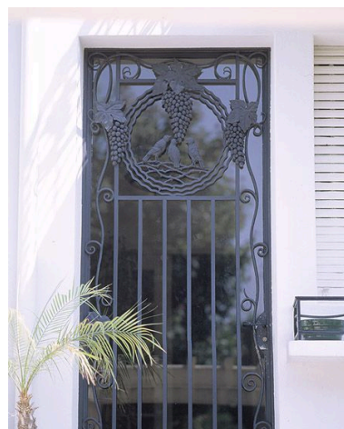
Détail de la porte d'entrée et de sa ferronnerie représentant des oiseaux picorant une grappe de raisin. Phot. Stéphane Asseline IVR11_20049400139XA
