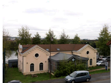
Vue générale et situation de l'ancienne usine élévatoire des eaux de Seine Phot. Philippe Ayrault IVR11_20167800647NUC4A
