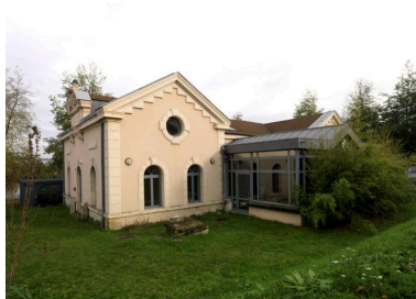
Vue de l'aile gauche du bâtiment, ouvrant sur la promenade des Cordeliers. Phot. Philippe Ayrault IVR11_20167800650NUC4A
