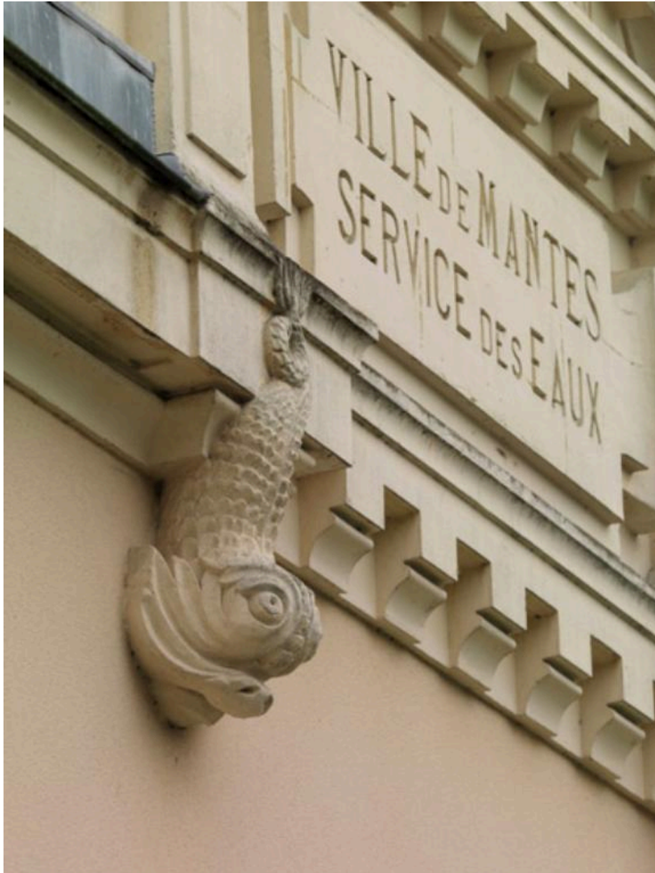
Vue d'une console en forme de triton supportant le fronton.
