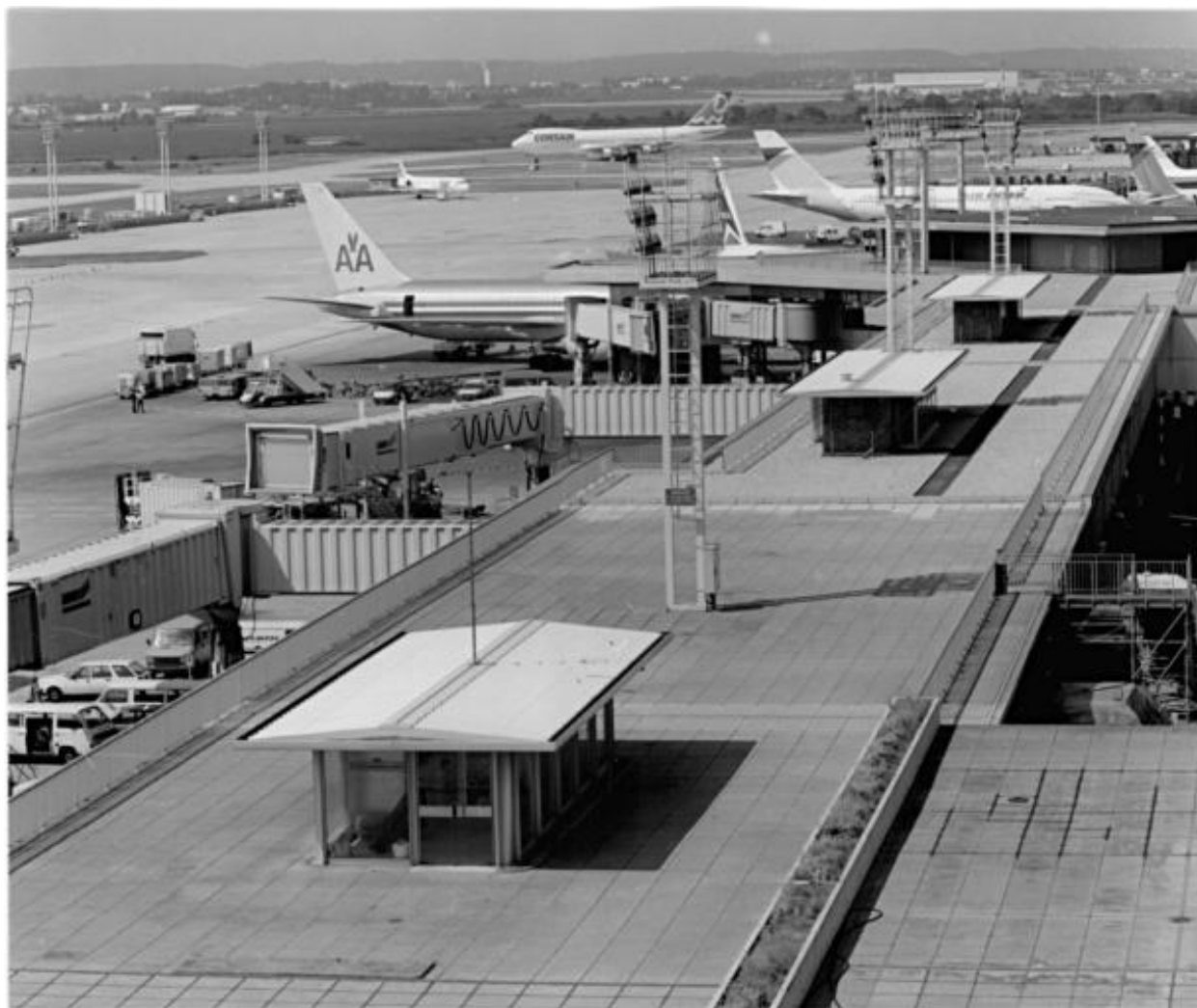
1992, terrasse de la jetée ouest, 4ème étage.
