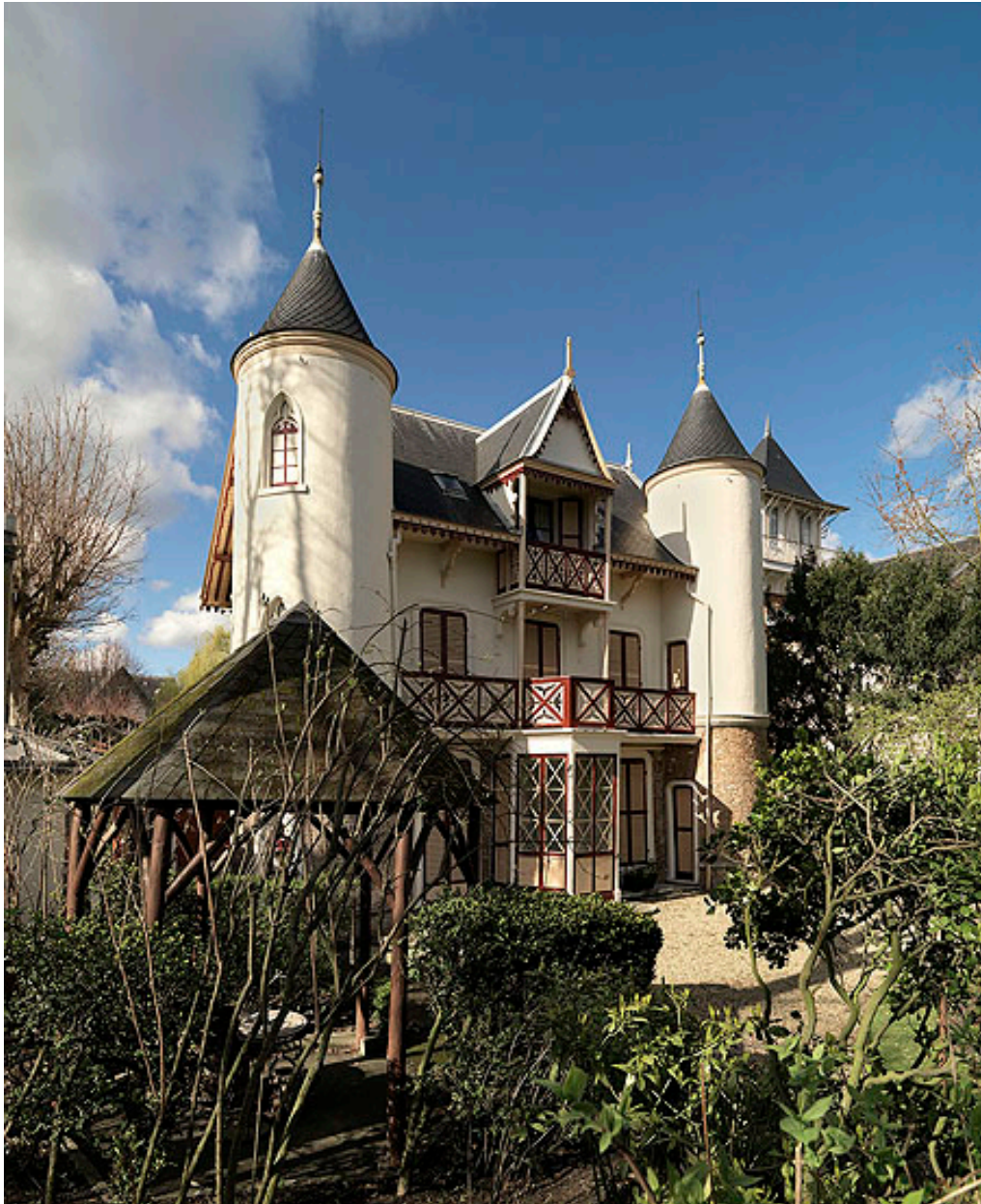
Vue de la façade donnant sur le lac.
