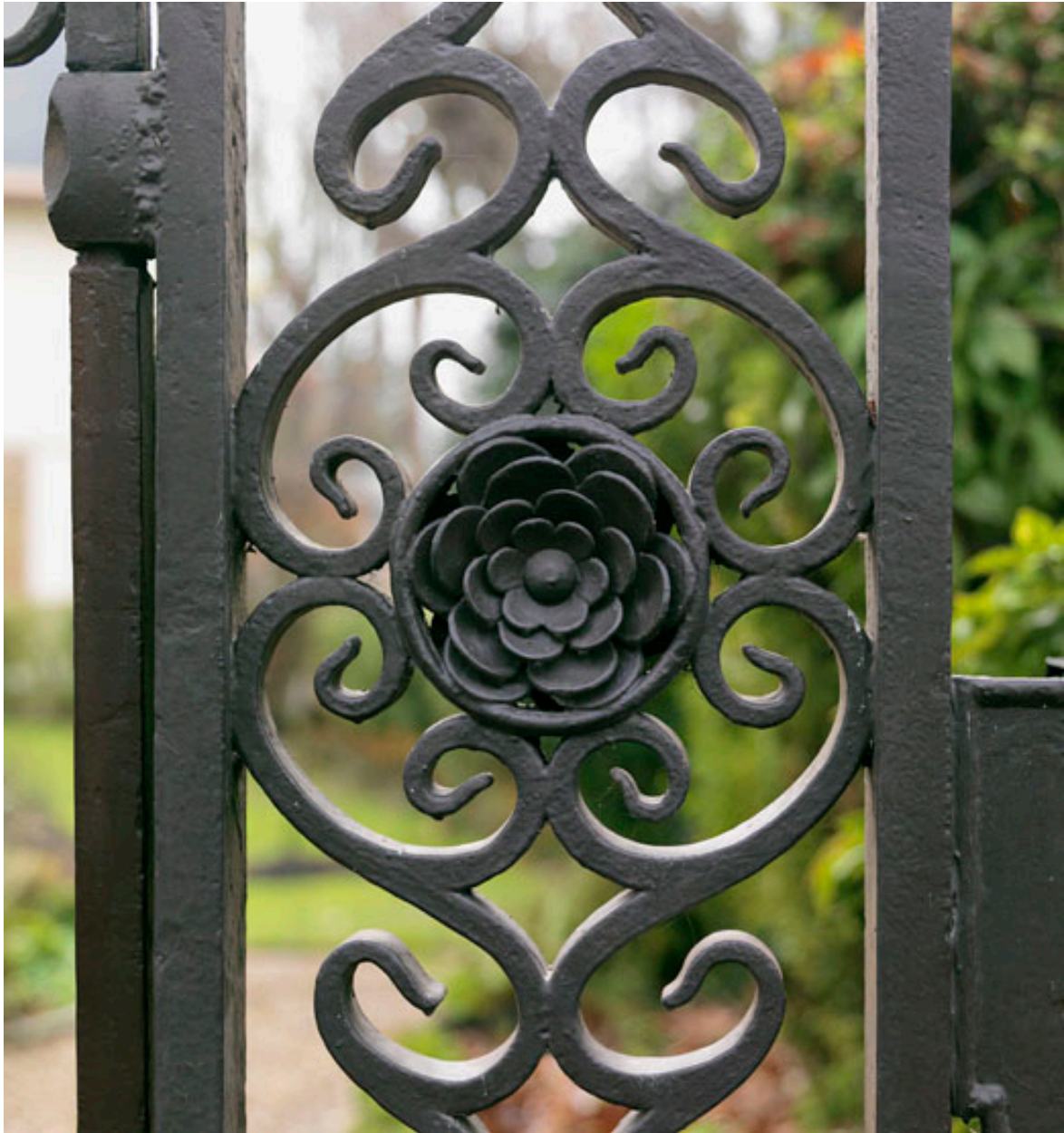
Détail de la ferronnerie du portail : rosace.
