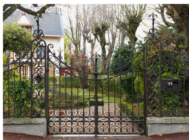
Vue d'ensemble du portail en ferronnerie. Phot. Jean-Bernard Vialles IVR11_20089500604NUC4A
