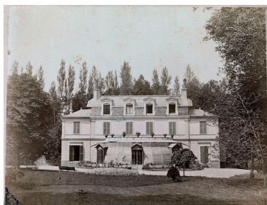
Vue d'ensemble de la façade sur jardin, ornée d'une grande serre. (AM Enghien-les-Bains, R154, Album ""le Windsor"") Phot. Jean-Bernard Vialles, Autr. Charles (photographe) Vogt IVR11_20099500568NUC4AB
