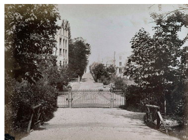
Vue de l'entrée du parc. Sur le côté à gauche figure le Kursaal alors en construction et qui ne sera jamais achevé. (AM Enghien-les-Bains, R154, Album ""le Windsor"") Phot. Jean-Bernard Vialles, Autr. Charles (photographe) Vogt IVR11_20099500572NUC4AB
