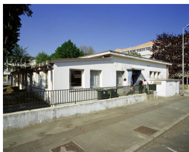
Vue du bâtiment de la cantine et du centre de loisirs maternels, situé à côté de l'entrée du 'Jardin Extraordinaire'. Phot. Philippe Ayrault IVR11_20039100684XA
