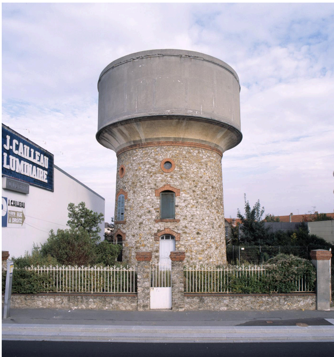
Vue d'ensemble du château d'eau en bordure de la RN 7.
