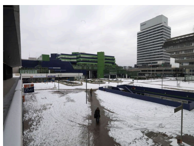
Vue de l'entrée de la piscine sur le parvis de la Préfecture. Phot. Laurent Kruszyk IVR11_20129500038NUC4A
