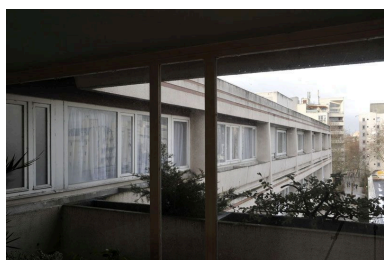
Patinoire : vue de la façade des logements. Phot. Laurent Kruszyk IVR11_20129500287NUC4A
