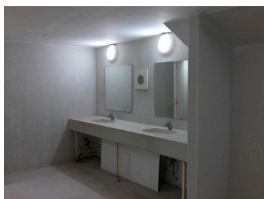
Piscine : vue de l'espace des sanitaires qui ont encore leur aménagement initial. Phot. Laurent Kruszyk IVR11_20129500341NUC4A
