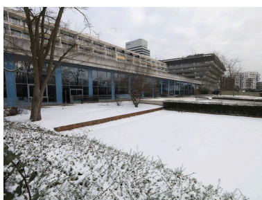
Elévation de la piscine côté jardin. Phot. Laurent Kruszyk
