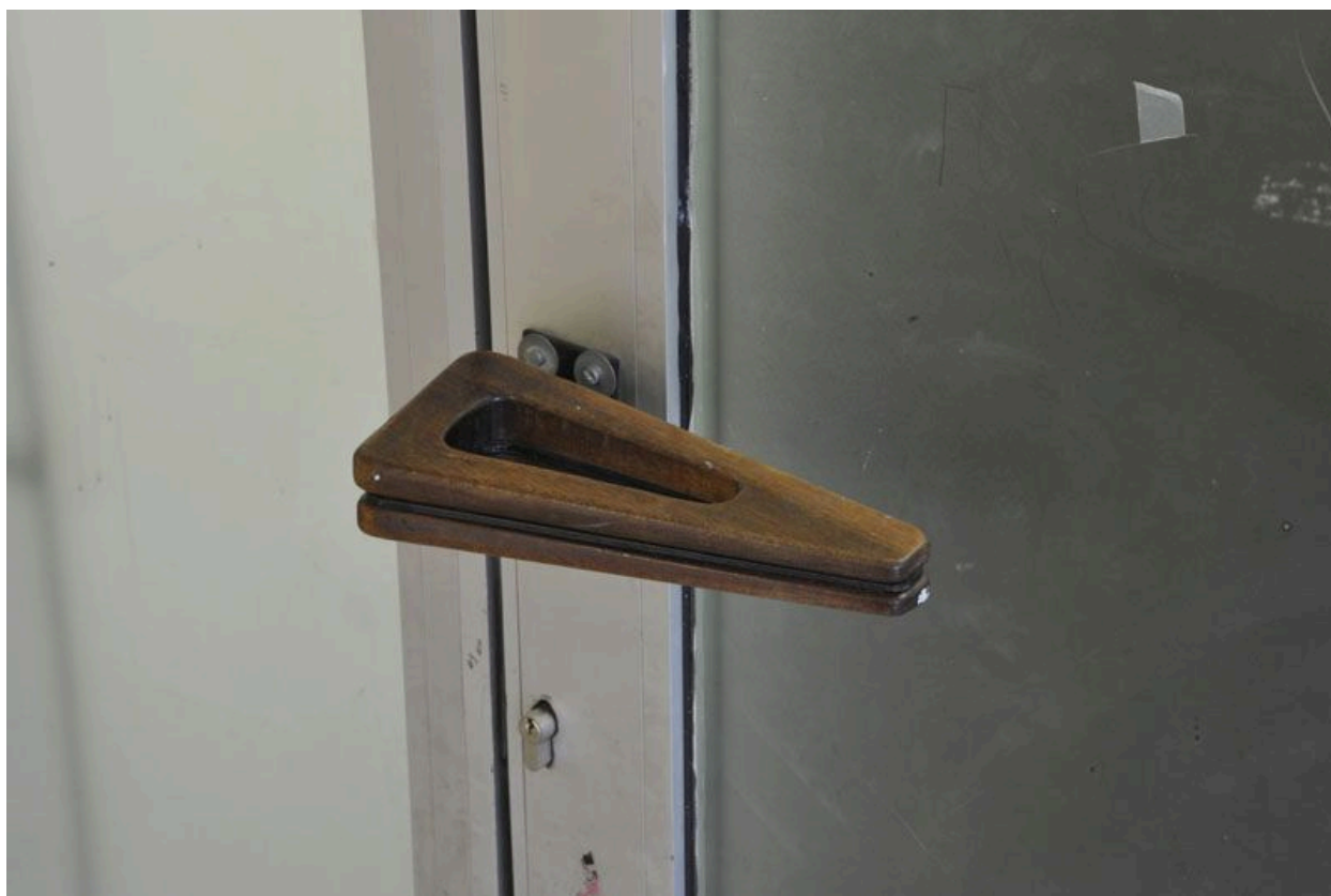
Patinoire : détail d'une poignée de porte contemporaine de la construction de l'édifice.
