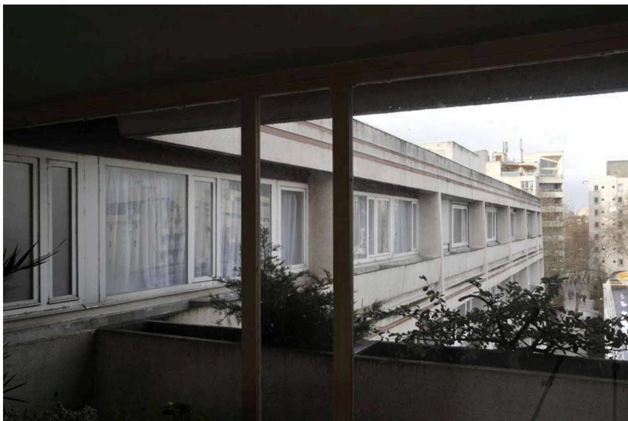
Patinoire : vue de la façade des logements.
