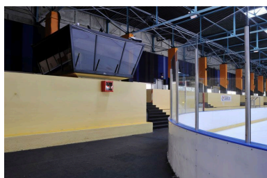
Vue de l'espace de circulation autour de la patinoire avec à gauche la cabine vue de l'extérieur. Phot. Laurent Kruszyk IVR11_20129500273NUC4A
