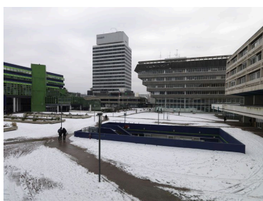
Vue de l'entrée de la piscine sur le parvis de la Préfecture. Phot. Laurent Kruszyk IVR11_20129500039NUC4A
