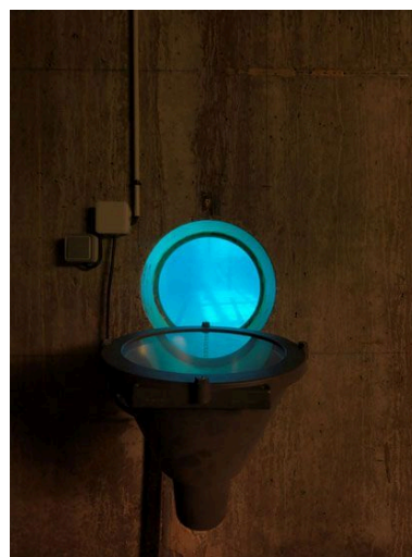
Piscine : détail d'un espace technique en sous-sol, couloir de circulation autour du bassin avec l'un des oculi donnant vers l'eau. Phot. Laurent Kruszyk IVR11_20129500343NUC4A
