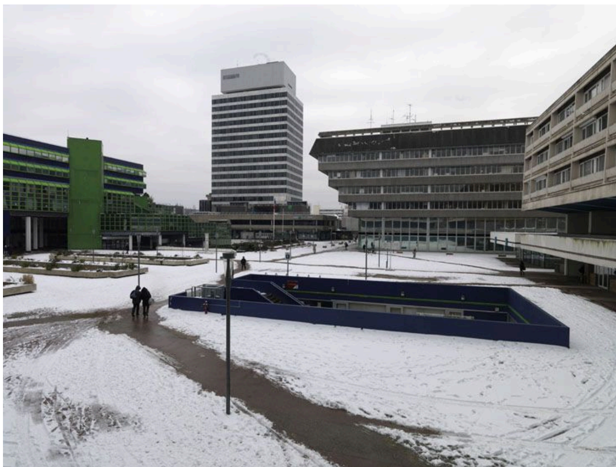
Vue de l'entrée de la piscine sur le parvis de la Préfecture.
