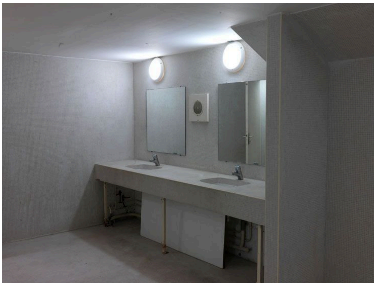
Piscine : vue de l'espace des sanitaires qui ont encore leur aménagement initial.
