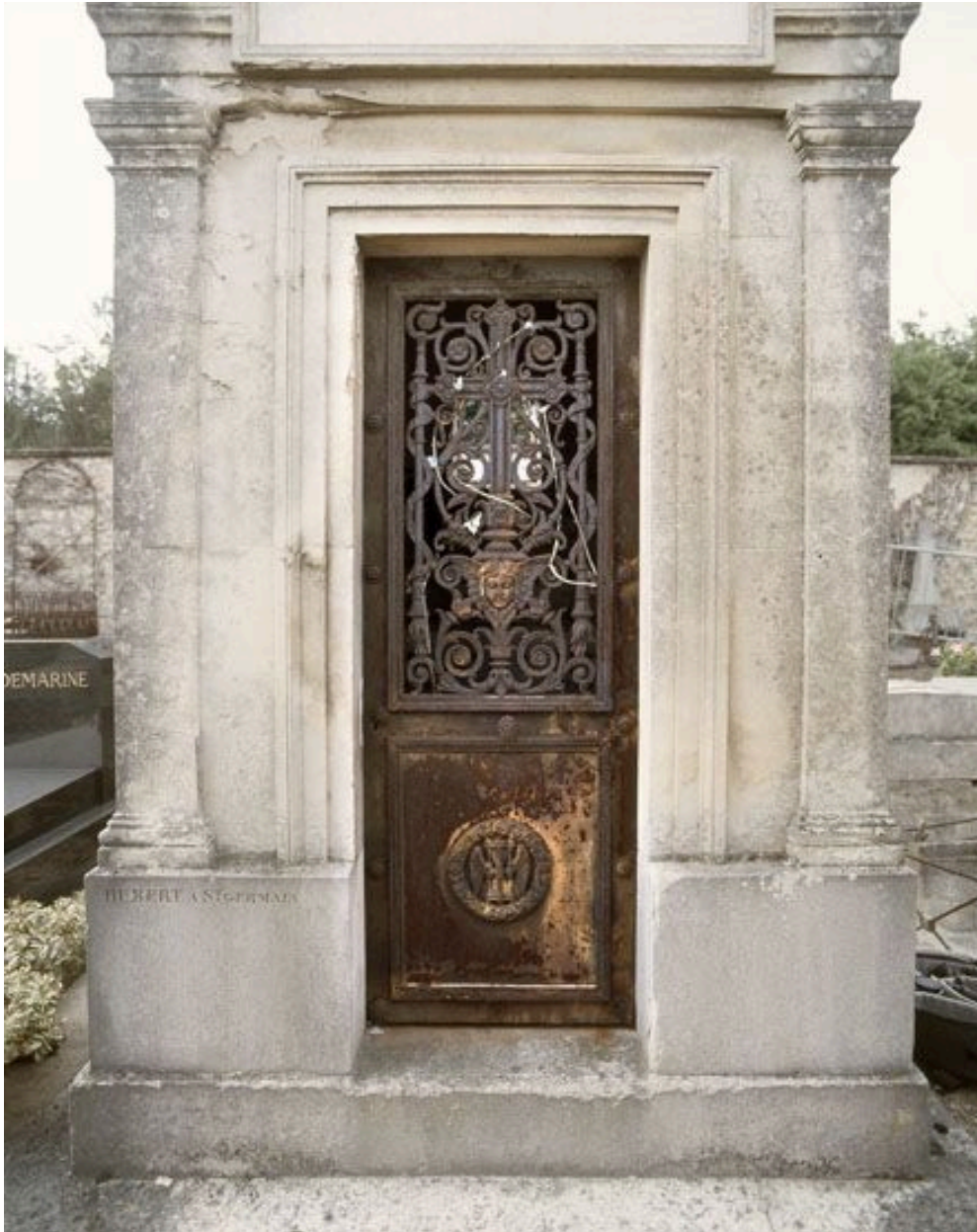
Détail de la porte en fonte.
