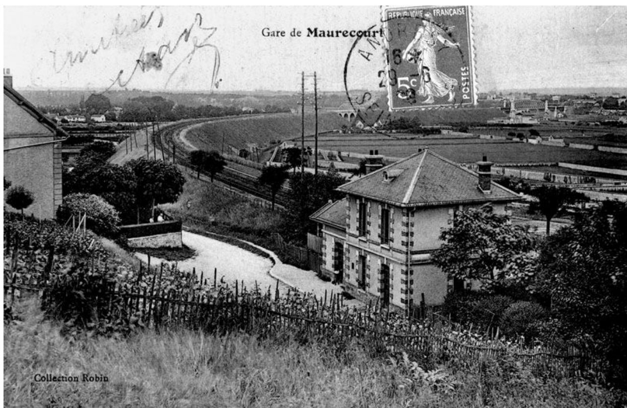
La halte de Maurecourt et le remblai de la voie ferrée vers Fin d'Oise. Carte postale. (Collection particulière).
