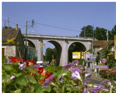
Vue d'ensemble du pont. Phot. Laurent Kruszyk IVR11_20067800881XA
