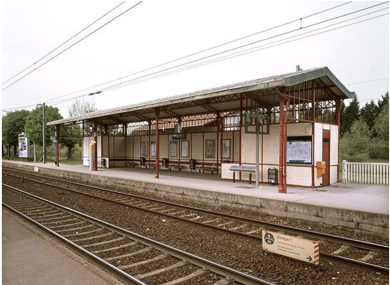
La gare d'Andrésey : vue du quai.
