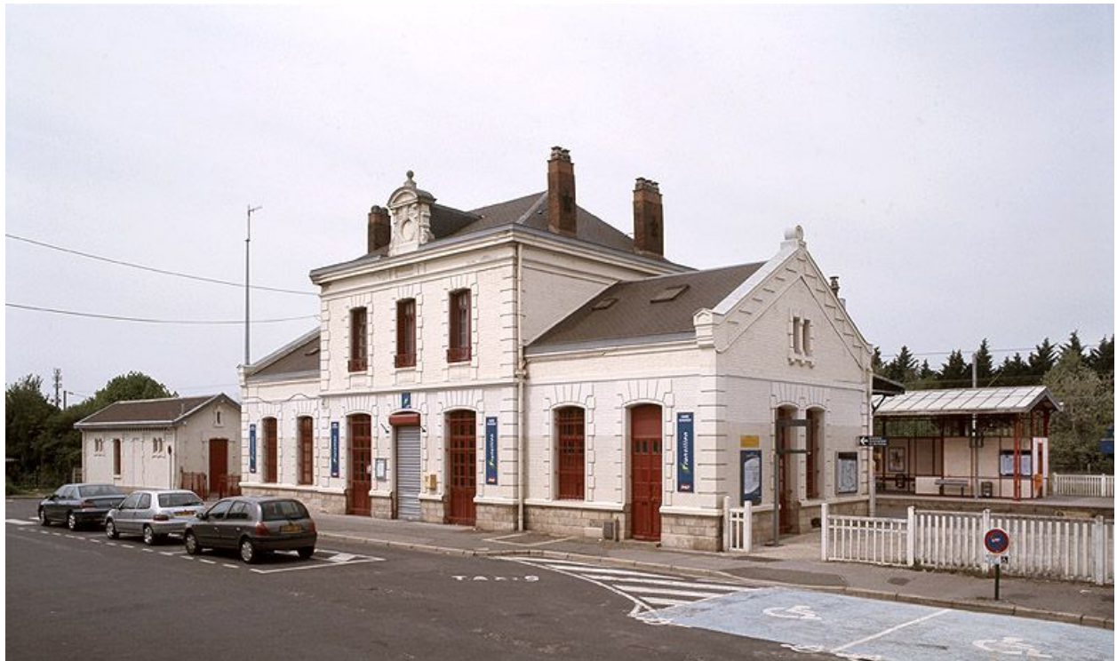
La gare d'Andrézy : façade antérieure.
