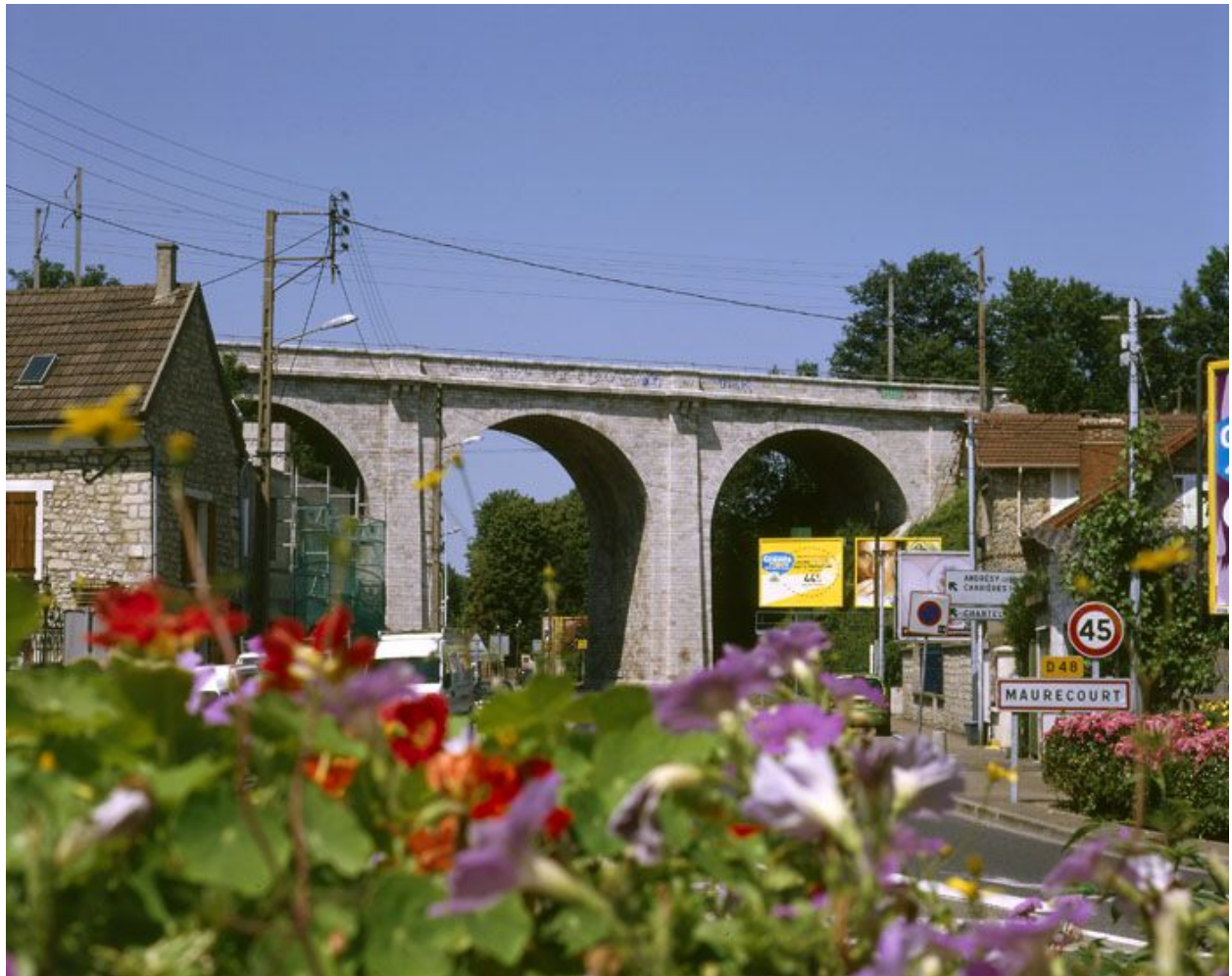
Vue d'ensemble du pont.
