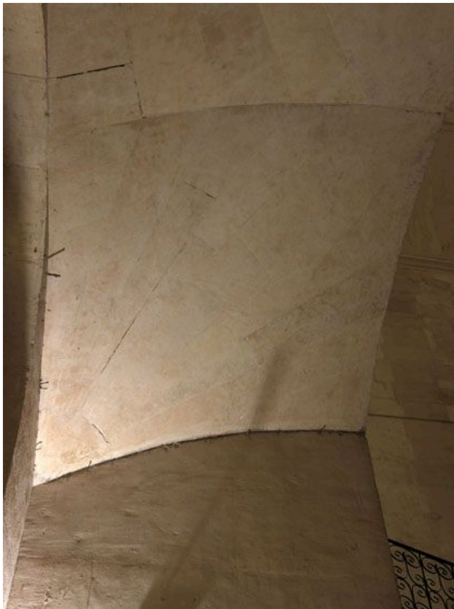
La voûte presque plate qui soutient le deuxième volée de l'escalier J.
