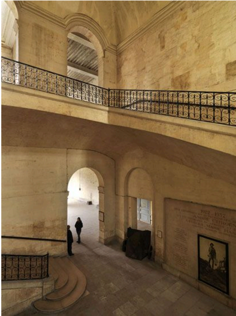
Vue d'ensemble du pavillon abritant la cage de l'escalier J à la jonction entre l'aile orientale et l'aile sud.
