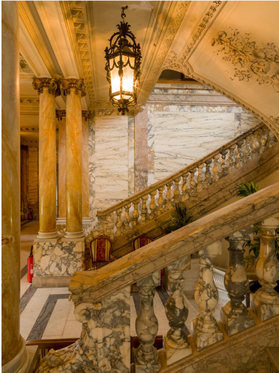
Départ de l'escalier, constitué de plusieurs types de marbres (différentes brèches dont la brèche du Benou jaune, peut-être de la brocatelle de Sienne)
