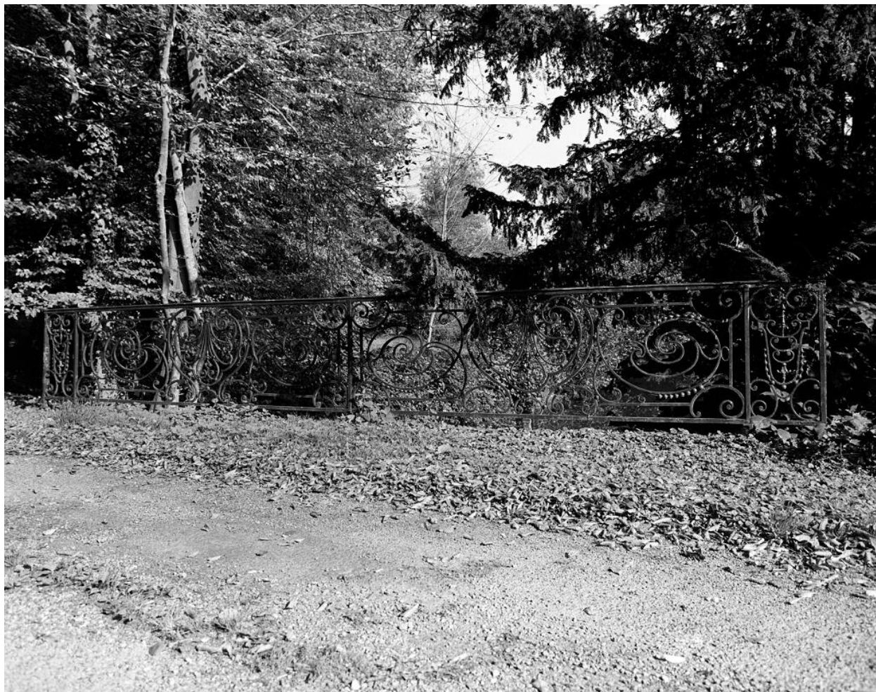
Garde-corps d'un pont dans le parc, en ferronnerie de style XVIIIe.
