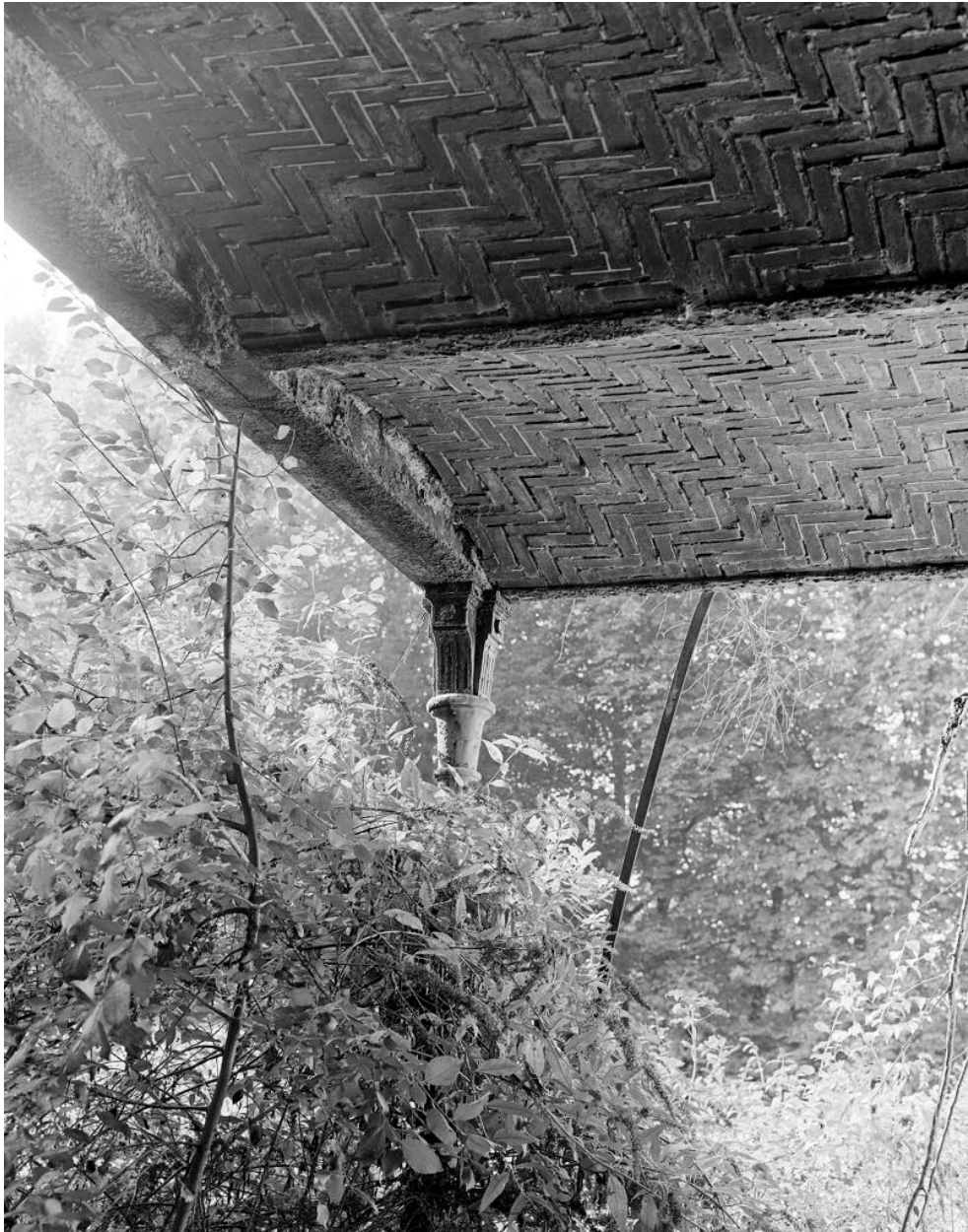
Vestiges des écuries. Voutain en brique sur armature métallique.
