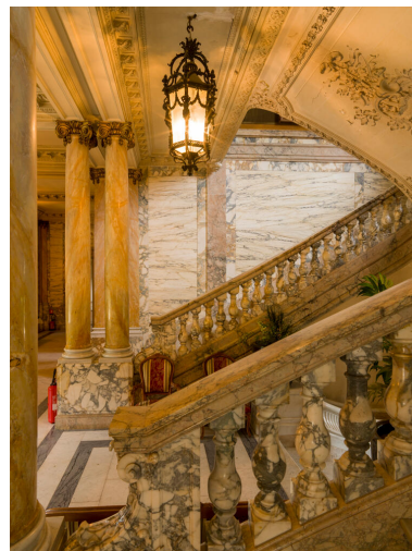
Départ de l'escalier, constitué de plusieurs types de marbres (différentes brèches dont la brèche du Benou jaune, peut- être de la brocatelle de Sienne) IVR11_20237800380NUC4A
