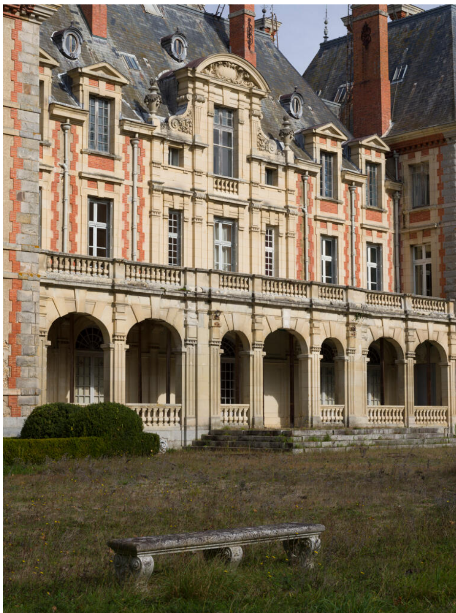
Galerie de la façade sud.
