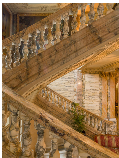
Détail des rampes à balustres de marbre veiné. Le limon est sculpté d'une frise de postes. IVR11_20237800378NUC4A
