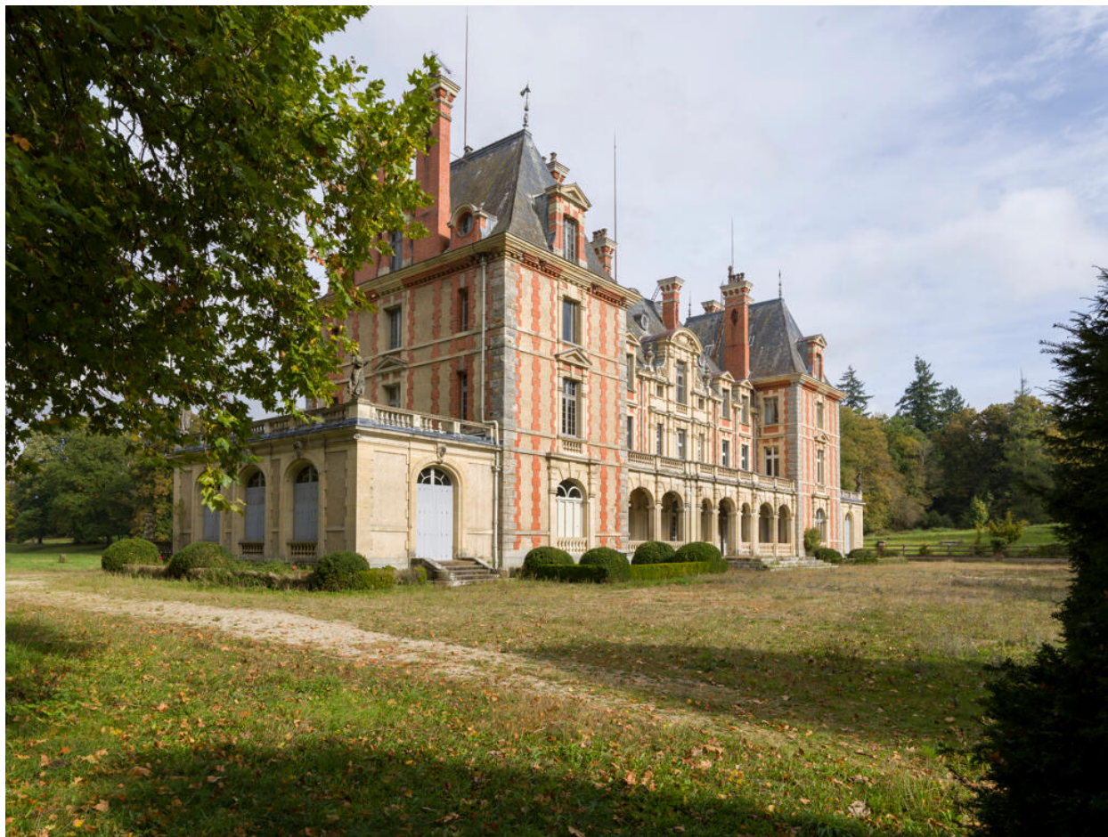
La façade sud et, au premier plan, à gauche, l'extension ouest.
