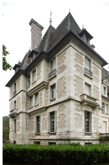
La façade latérale sud. La sévérité de la mise en oeuvre de la maçonnerie est ici bien lisible. La pierre de taille de Château-Landon encadre les moellons de Souppes, au-dessus d'un soubassement à
