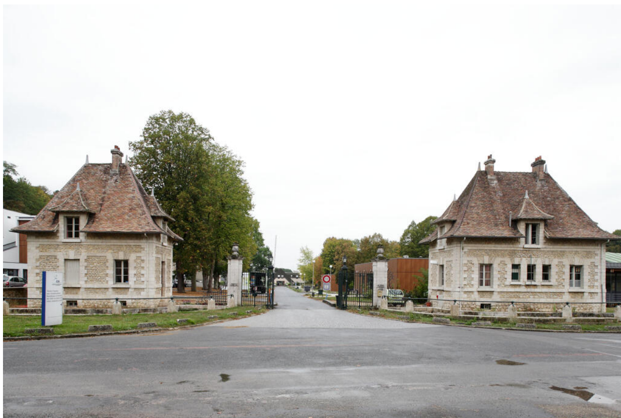
L'entrée du domaine, flanquée de deux pavillons.
