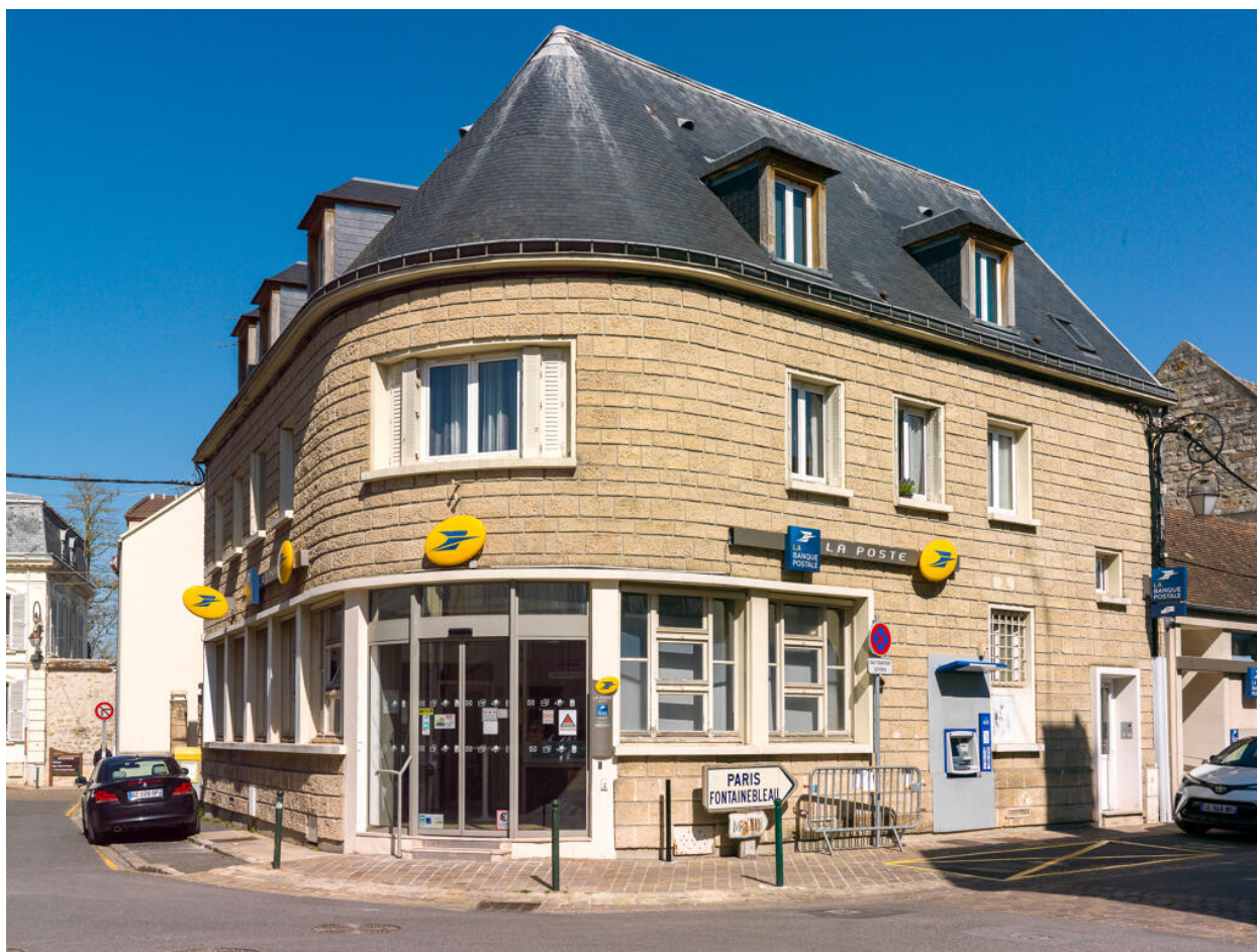
Vue générale de la Poste depuis le sud.
