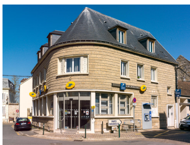
Vue générale de la Poste depuis le sud. Phot. Asseline Stéphane IVR11_20259100154NUC4A
