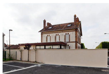
Logement du concierge. (réf. Département de Seine-et-Marne : IVD77_2013_77_00359_NUCA) Phot. Yvan Bourhis IVR11_20197700560NUC4A
