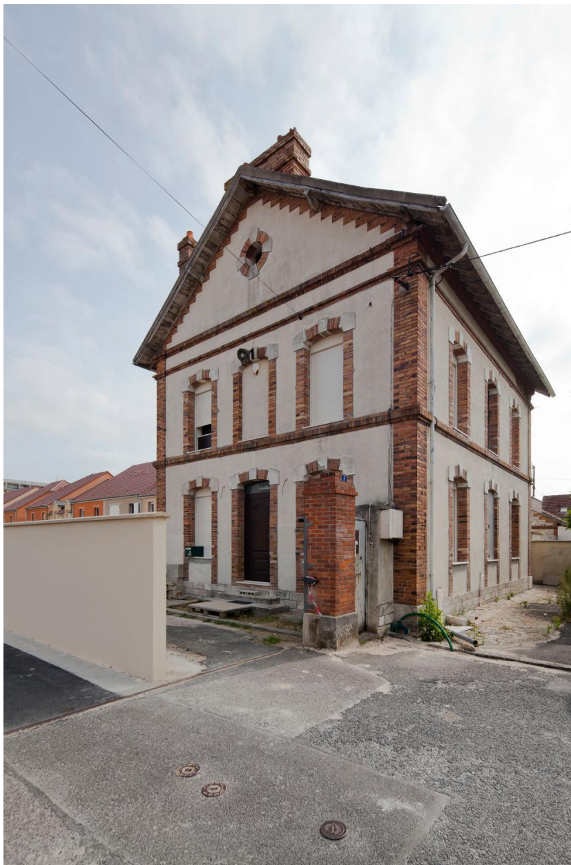
Logement du concierge. (réf. Département Seine-et-Marne : IVD77_2013_77_00357_NUCA)
