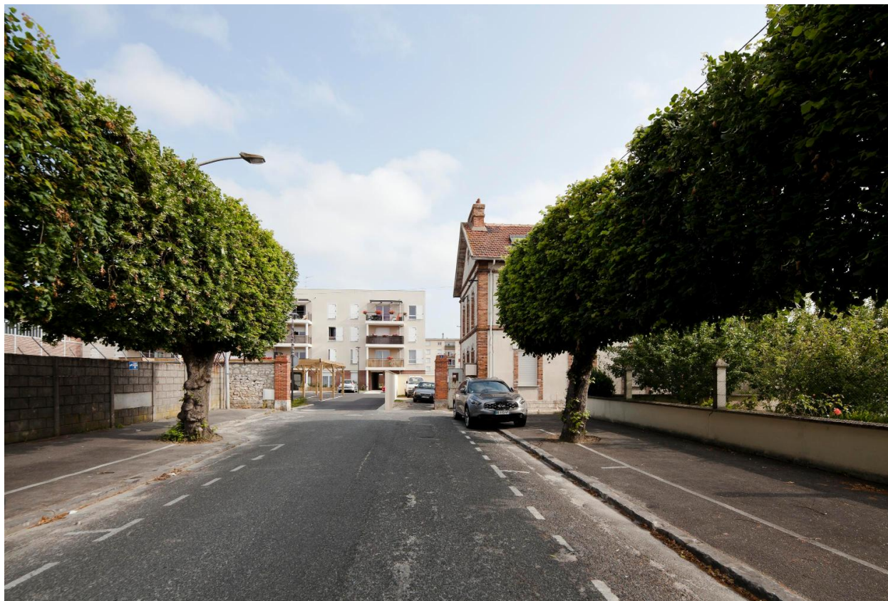
Entrée principale et logement du concierge. (réf. Département Seine-et-Marne : IVD77_2013_77_00356_NUCA)
