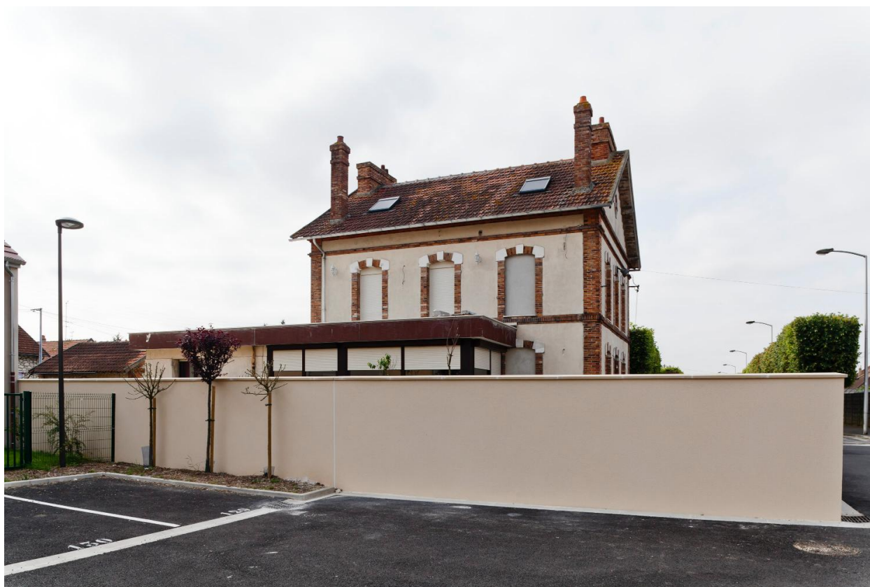
Logement du concierge. (réf. Département de Seine-et-Marne : IVD77_2013_77_00359_NUCA)
