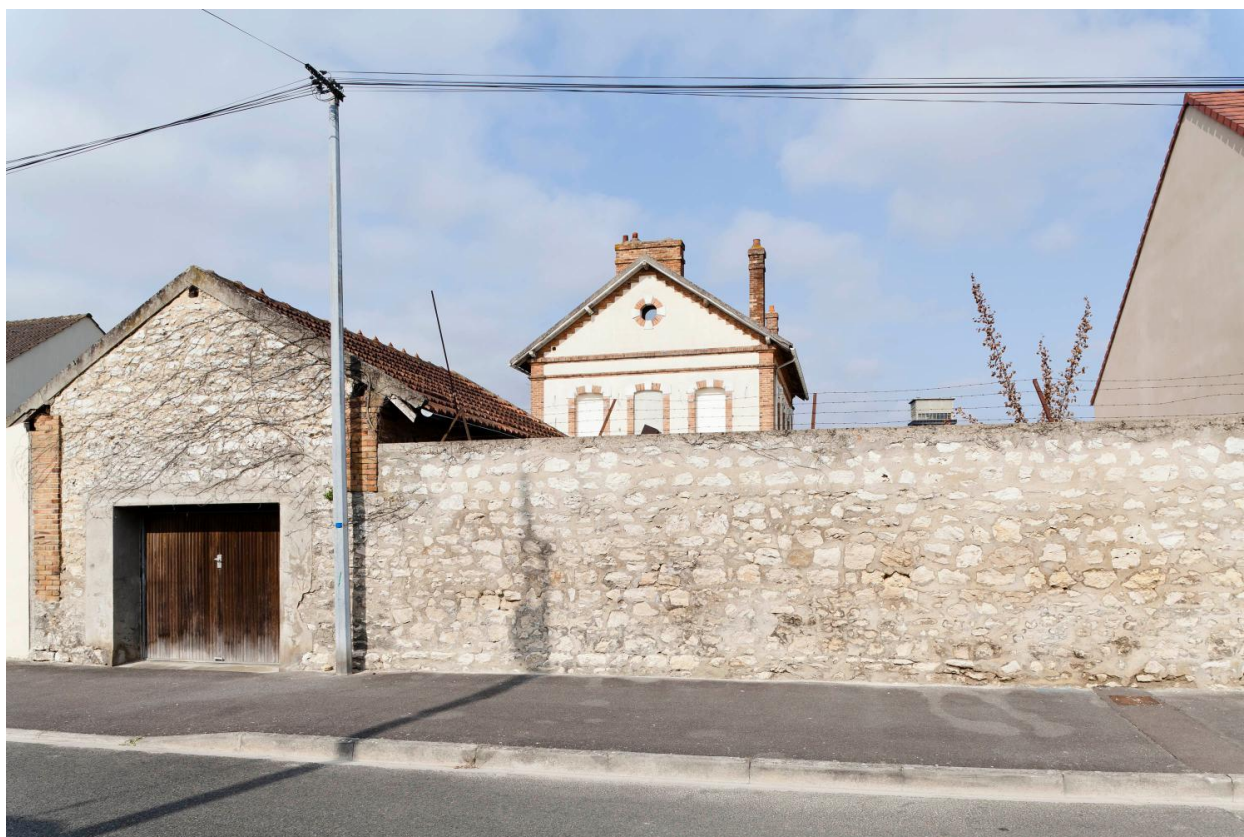
Mur d'enceinte, machine élévatoire, logement du concierge. (réf. Département Seine-et-Marne : IVD77_2013_77_00358_NUCA)
