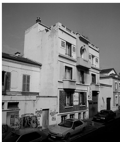
Vue de la façade prise du sud. Phot. Jean-Bernard Vialles IVR11_20029300212X
