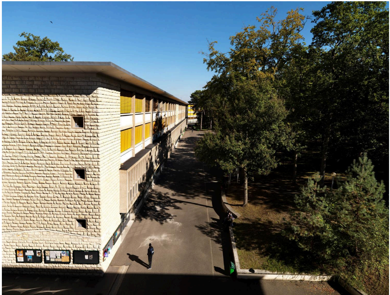
Les murs-pignons revêtus de moellons de calcaire.
