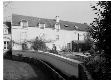
Vue du seul vestige de la ferme. Phot. Christian Décamps IVR11_20007800210X
