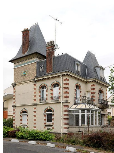
Elévations ouest et sud. Phot. Jean-Bernard Vialles IVR11_20127700824NUC4A
