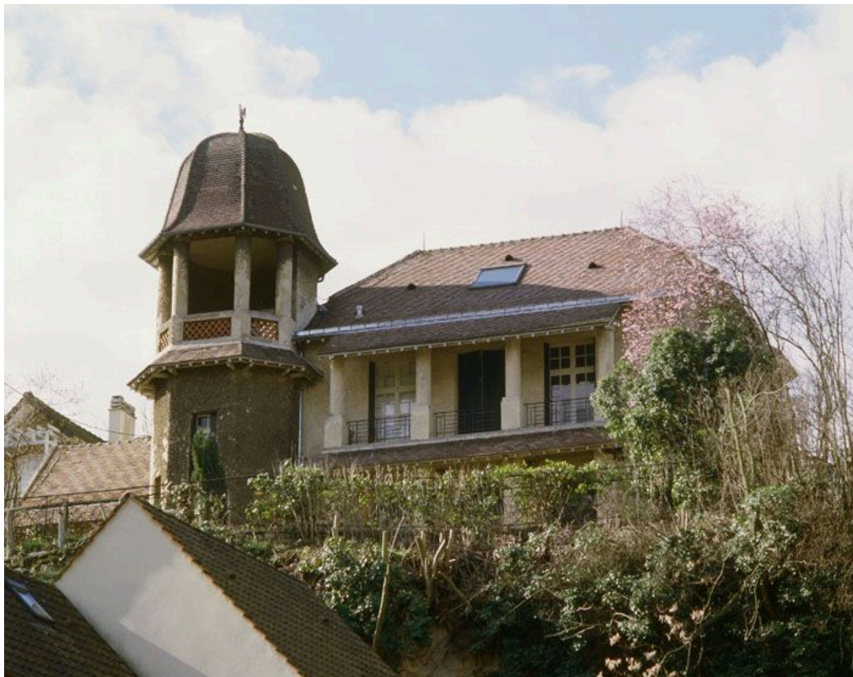
Vue d'ensemble de la façade panoramique.
