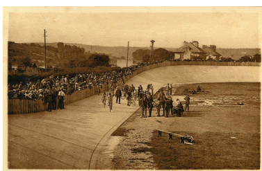
Photo ancienne d'une course dans le vélodrome. Repro. Académie François Bourdon-Le Creusot IVR11_20117700104NUC
