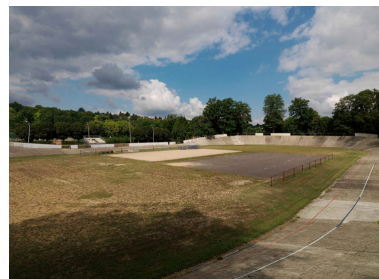
Vue de la piste en béton de 250 mètres avec des pentes de 7 à 37 degrés dans les courbes. Phot. Philippe Ayrault IVR11_20117700713NUC4A
