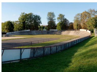
Vue de la piste en béton de 250 mètres avec des pentes de 7 à 37 degrés dans les courbes. Phot. Philippe Ayrault IVR11_20117700714NUC4A
