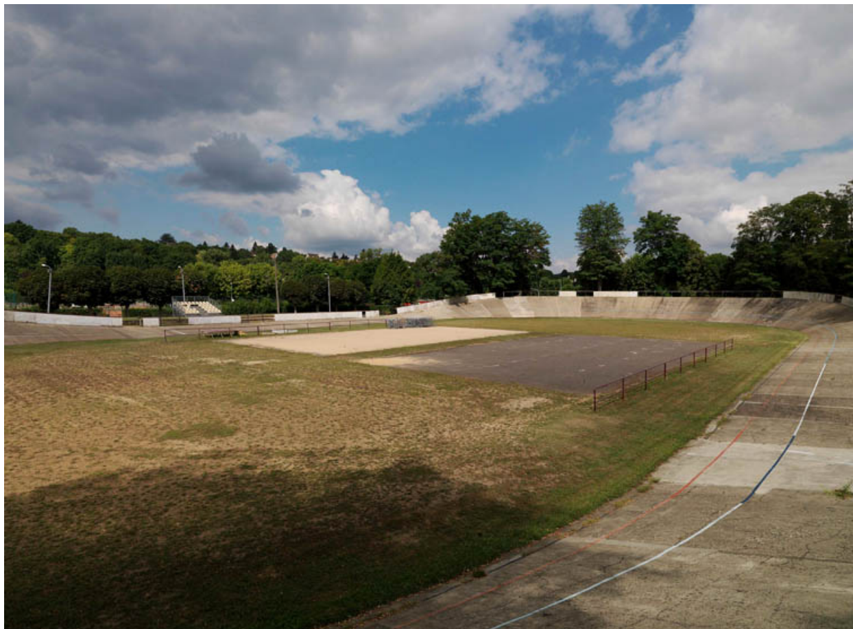
Vue de la piste en béton de 250 mètres avec des pentes de 7 à 37 degrés dans les courbes.
