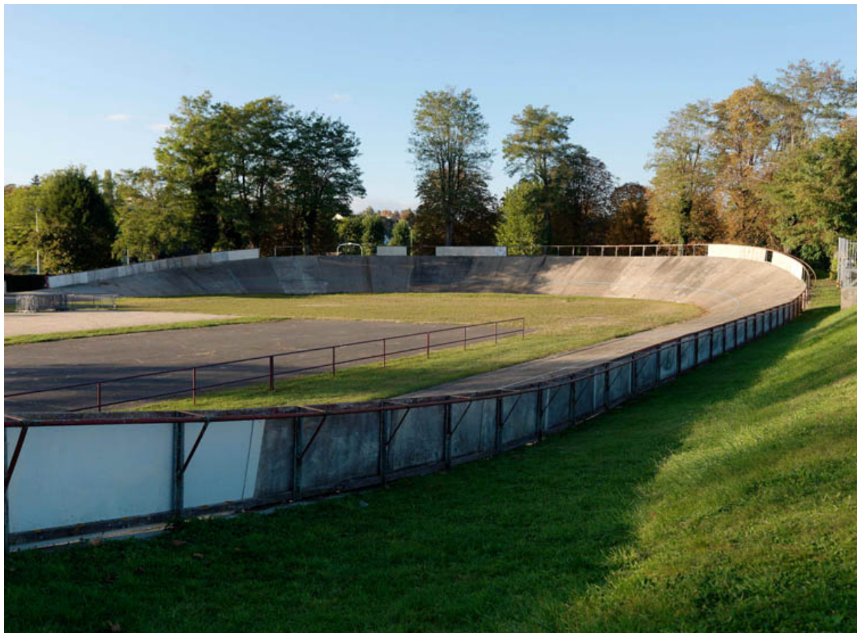
Vue de la piste en béton de 250 mètres avec des pentes de 7 à 37 degrés dans les courbes.
