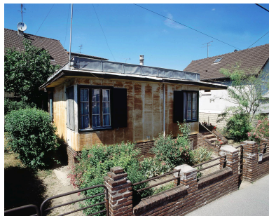
Vue d'ensemble. Phot. Philippe Ayrault IVR11_20019100247XA
