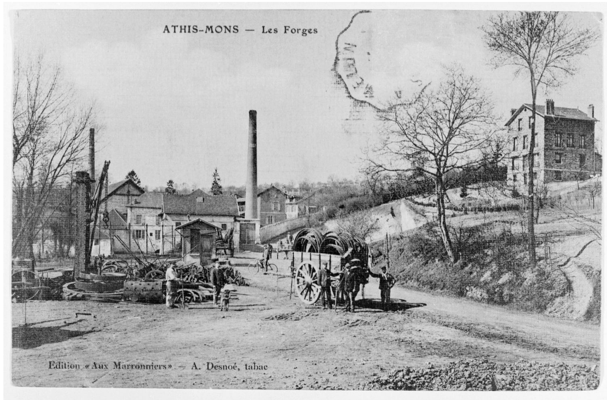
Vue de l'ensemble du site.
