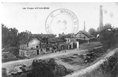
Vue d'ensemble des bâtiments. IVR11_20029101928NUCB
