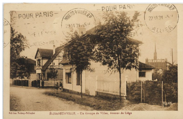
Un groupe de villas, avenue de Liège. Carte postale, vers 1931. (Collection particulière). Phot. Laurent Kruszyk IVR11_20147800397NUC4A
