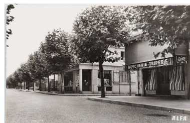
La rue du commerce. Photographie, 1929. (Collection particulière). Phot. Laurent Kruszyk IVR11_20147800330NUC4A
