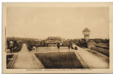
Avenue partant de la place de l'Etoile et le château d'eau. Carte postale, vers 1928. (Collection particulière). Phot. Laurent Kruszyk IVR11_20147800396NUC4A
