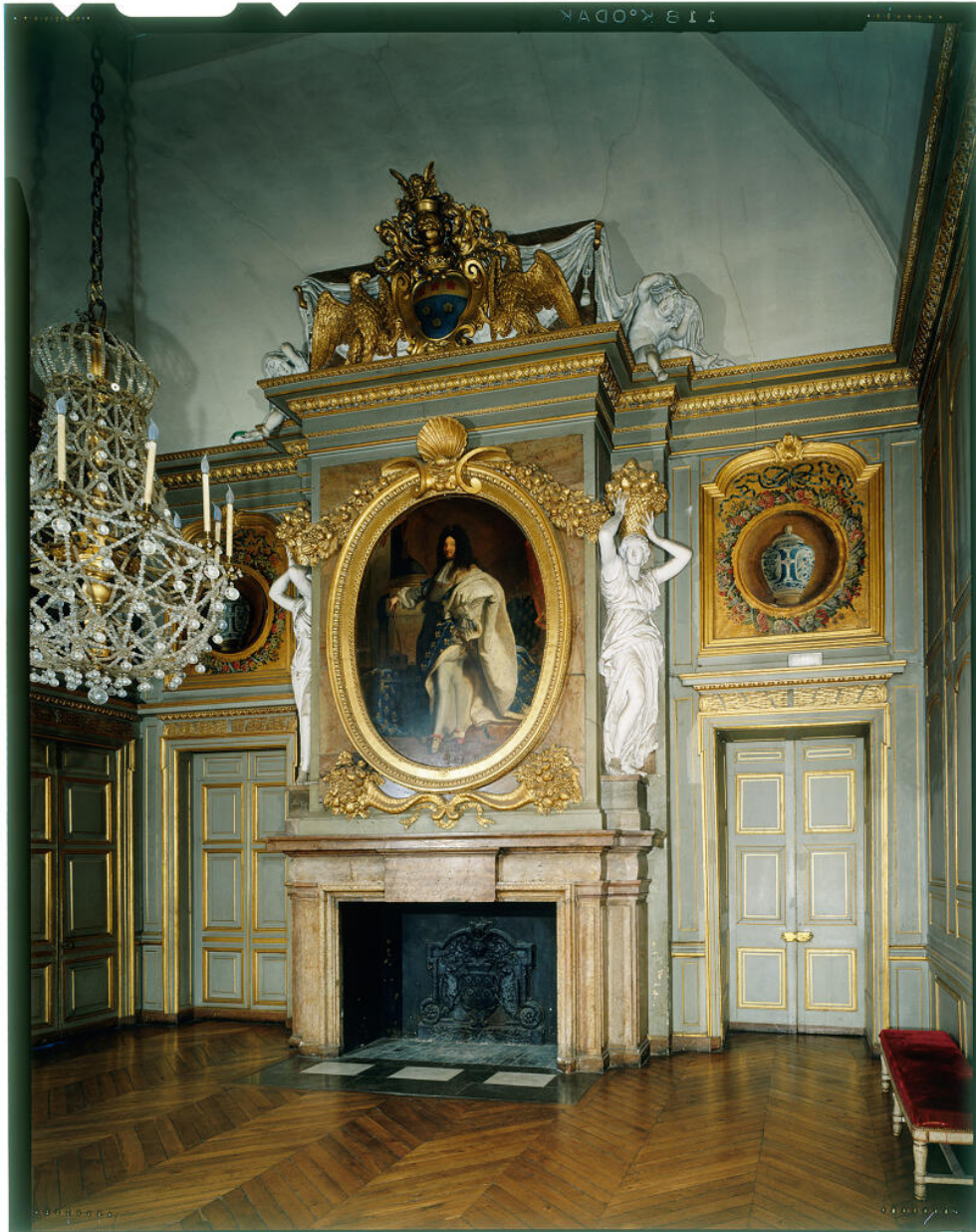
Cheminée de la grande salle de l'appartement du roi.
