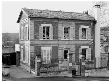
Vue d'ensemble. Phot. Christian Décamps IVR11_20007800102X
