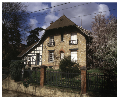
Vue des communs depuis la rue. Phot. Vialles Jean-Bernard IVR11_20027800043XA
