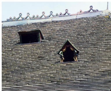
Détail de l'une des chatières sur le toit des communs : deux lutins se font face. Phot. Vialles Jean-Bernard IVR11_19967800420XA
