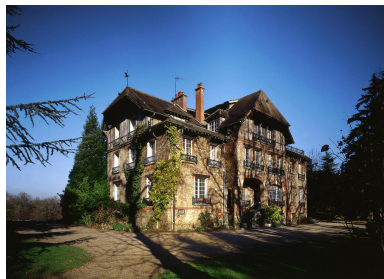
Vue de la façade antérieure. Phot. Vialles Jean-Bernard IVR11_20027800844VA
