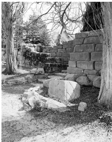
Vue du jardin du côté de l'embarcadère : des blocs en béton imitent un opus cyclopéen. Phot. Vialles Jean-Bernard IVR11_19967800421X
