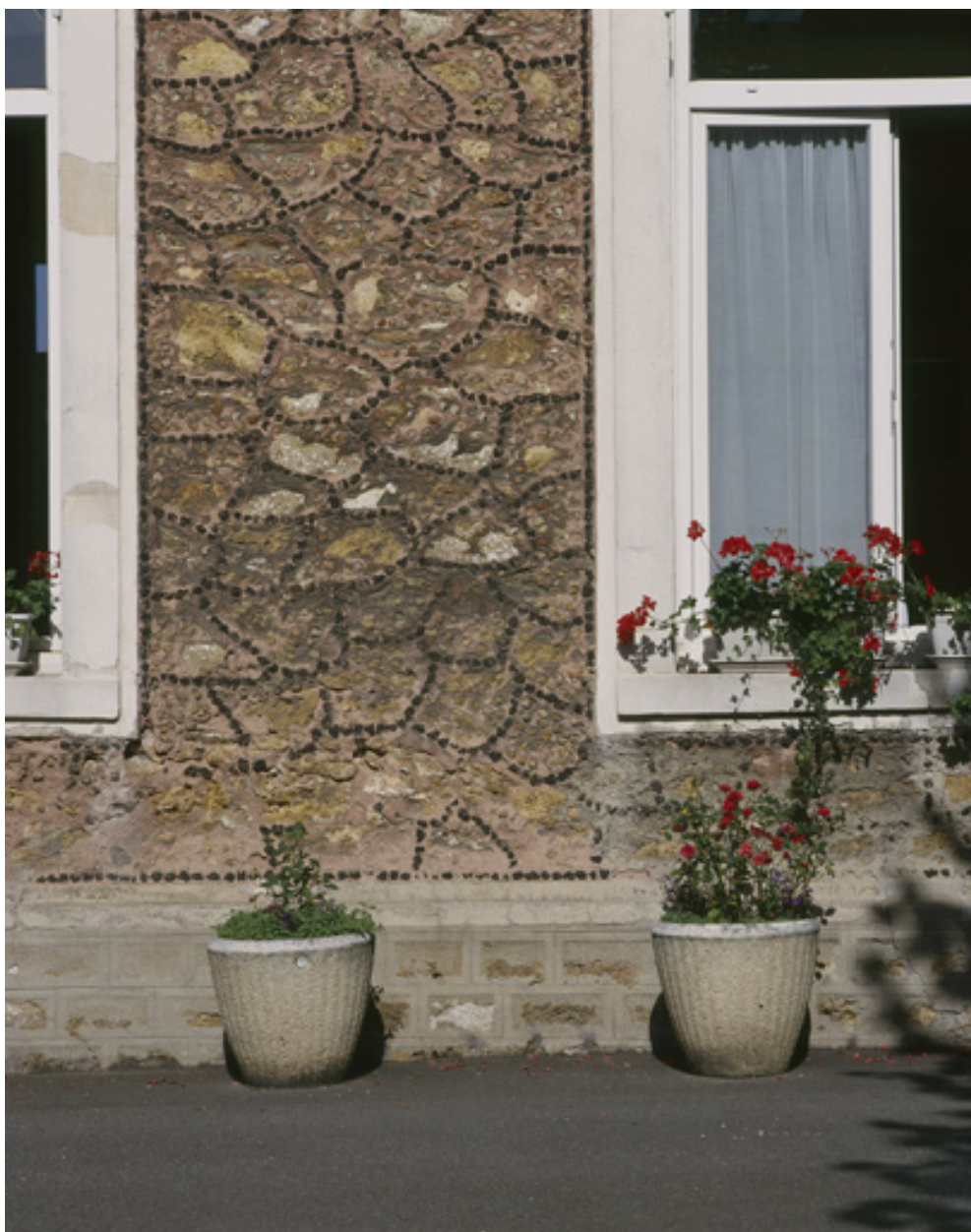
Bâtiments situés à l'arrière de la construction principale : détail de l'enduit rocaillé. Les blocs de meulière sont entourés de cailloux de mâchefer.
