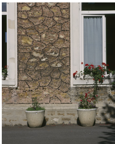
Bâtiments situés à l'arrière de la construction principale : détail de l'enduit rocaillé. Les blocs de meulière sont entourés de cailloux de mâchefer. Phot. Philippe Ayrault IVR11_20069101223XA
