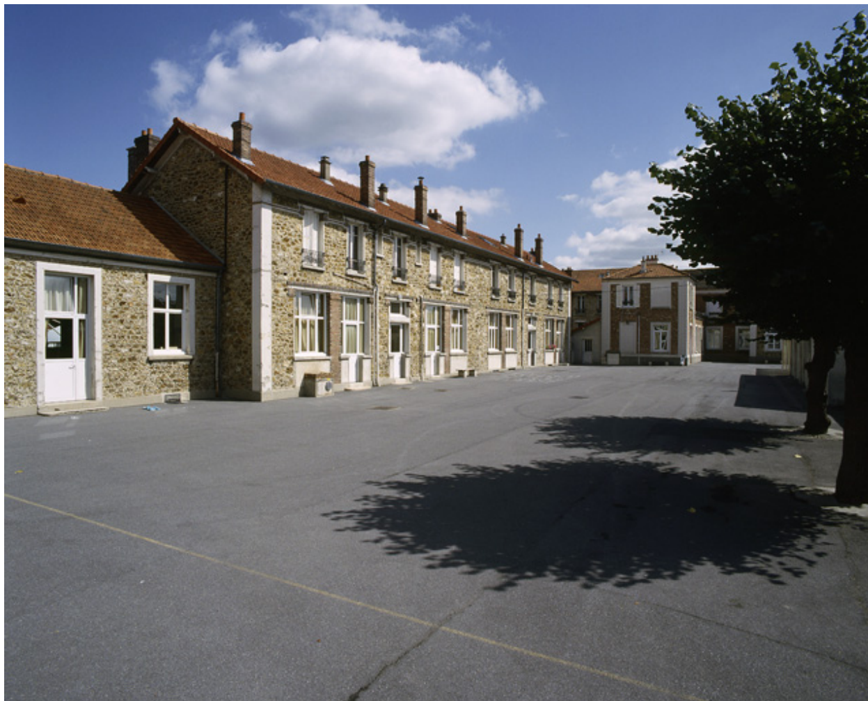
Vue des bâtiments construits en 1879 pour agrandir la première école de garçons. Au fond, l'édifice de logement qui porte la signature de l'entrepreneur E. Chaponnay.
