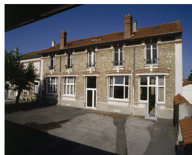
Bâtiments situés à l'arrière des bâtiments principaux, délimitant avec eux une petite cour. Ils correspondent à l'extension de 1879 (?). Phot. Philippe Ayrault IVR11_20069101221XA
