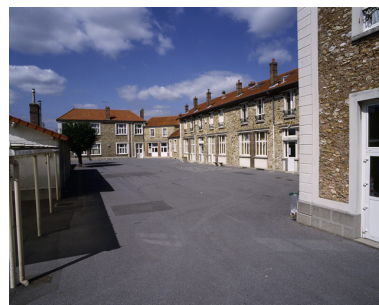
Vue d'ensemble sur la cour de récréation, en direction des bâtiments construits en 1930 au fond de cette cour. Phot. Philippe Ayrault IVR11_20069101213XA
