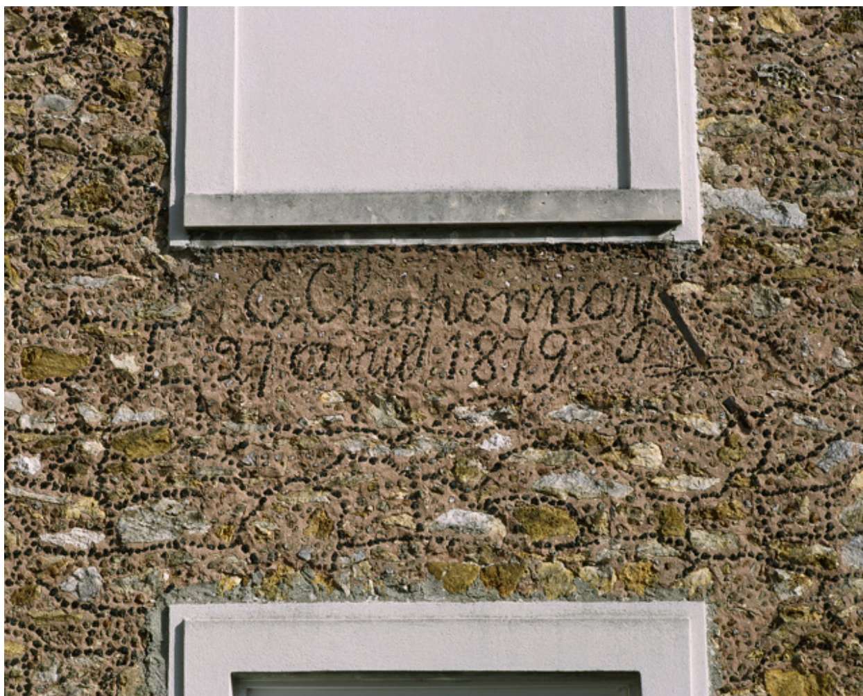
Signature de l'entrepreneur Chaponnay dessinée dans l'enduit en cailloux de mâchefer.
