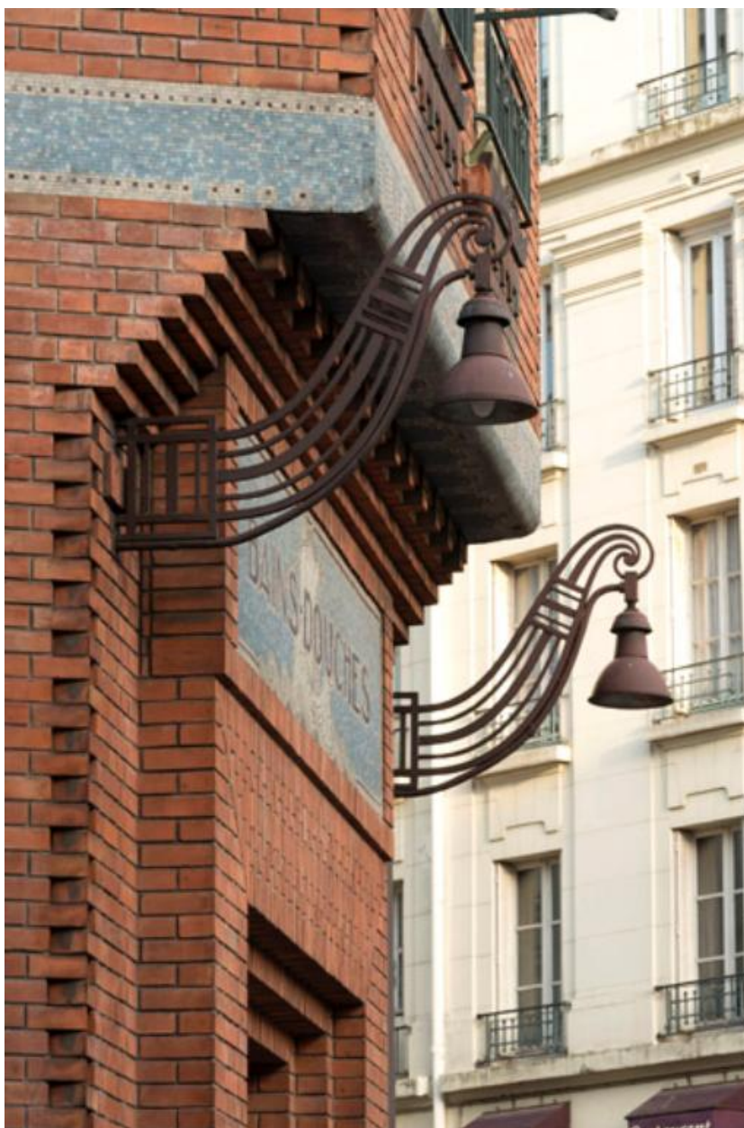
L'entrée de l'établissement et le travail de calepinage de la brique.
