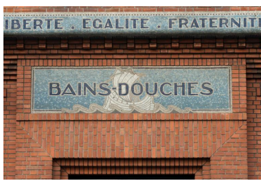
Détail de l'inscription "bains- douches" et du blason de la Ville de Paris (nef voguant sur les flots). Phot. Laurent Kruszyk IVR11_20167500793NUC4A
