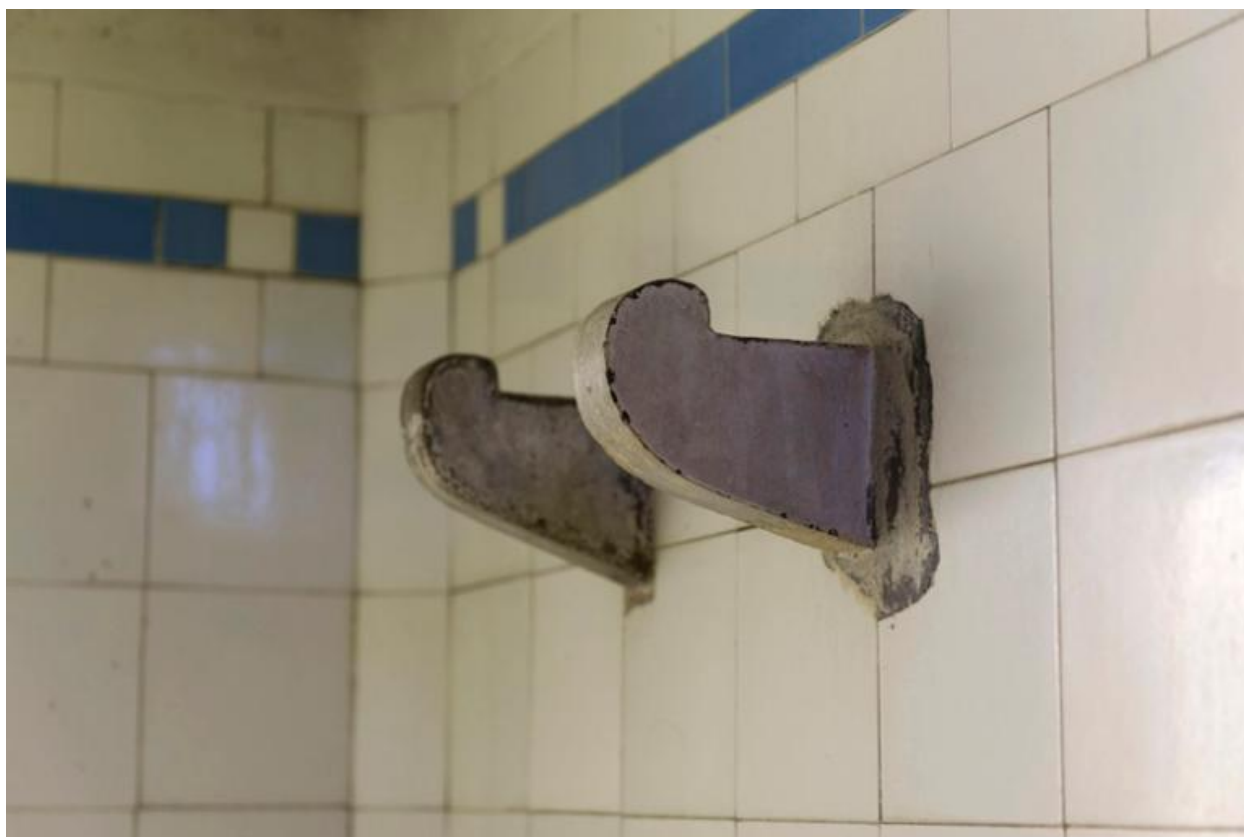
Patères en ciment, dans une cabine de douche.
