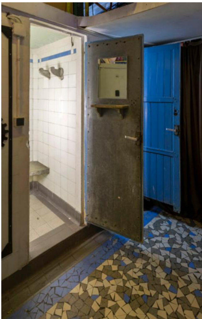
Sols en grès cérame et portes en bois des cabines de douches, avec tablette et miroir.
