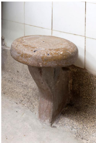
Un "champignon", petit siège en ciment permettant à l'utilisateur des bains-douches de s'asseoir ou de poser un pied pour se nettoyer le bas du corps.
