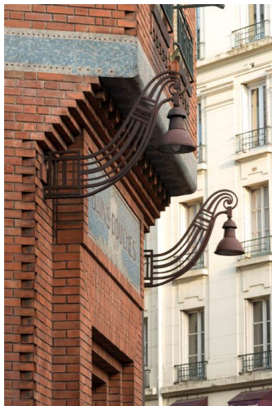
L'entrée de l'établissement et le travail de calepinage de la brique. Phot. Laurent Kruszyk IVR11_20167500795NUC4A
