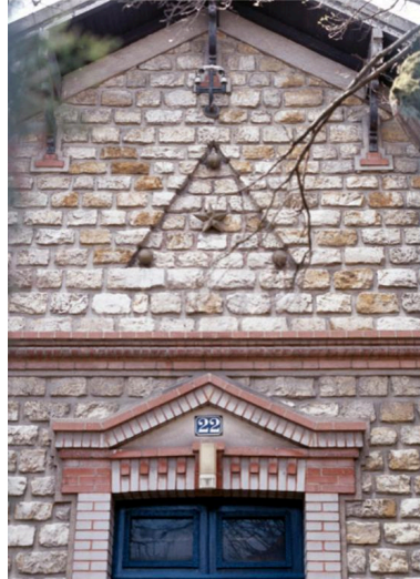
Détail du pignon, orné du triangle maçonnique. Phot. Stéphane Asseline IVR11_20067700441XA
