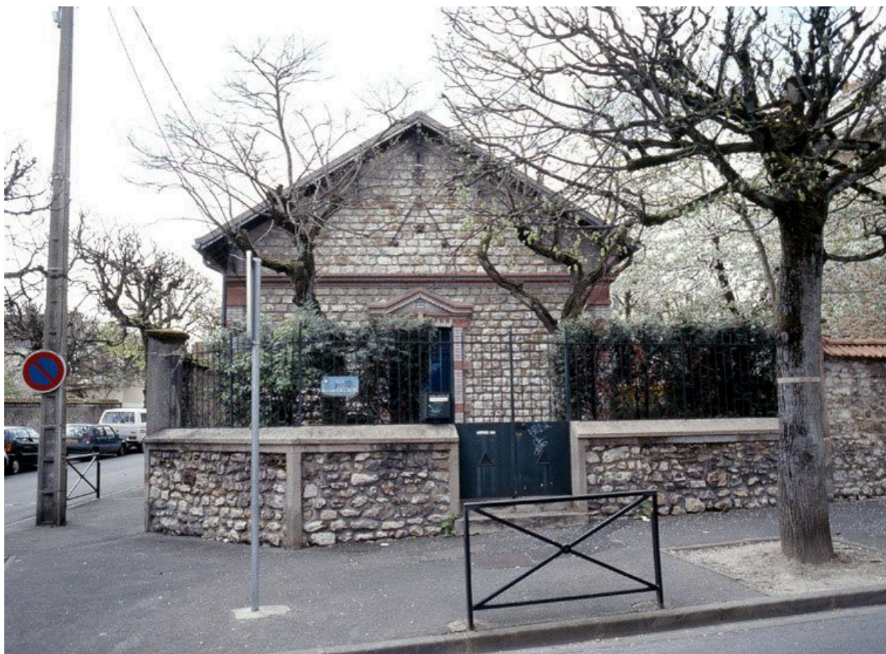
Vue d'ensemble, depuis la rue.
