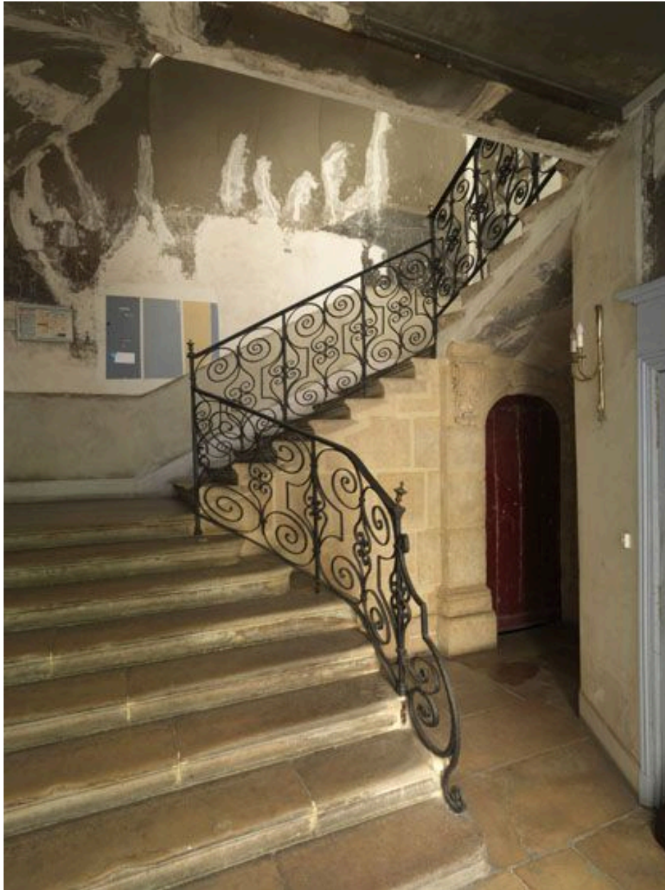
Vue du départ de l'escalier et de sa première volée.
