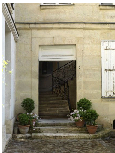
La porte desservant l'escalier à rampe de fer. Phot. Philippe Ayrault IVR11_20107500399NUC4A
