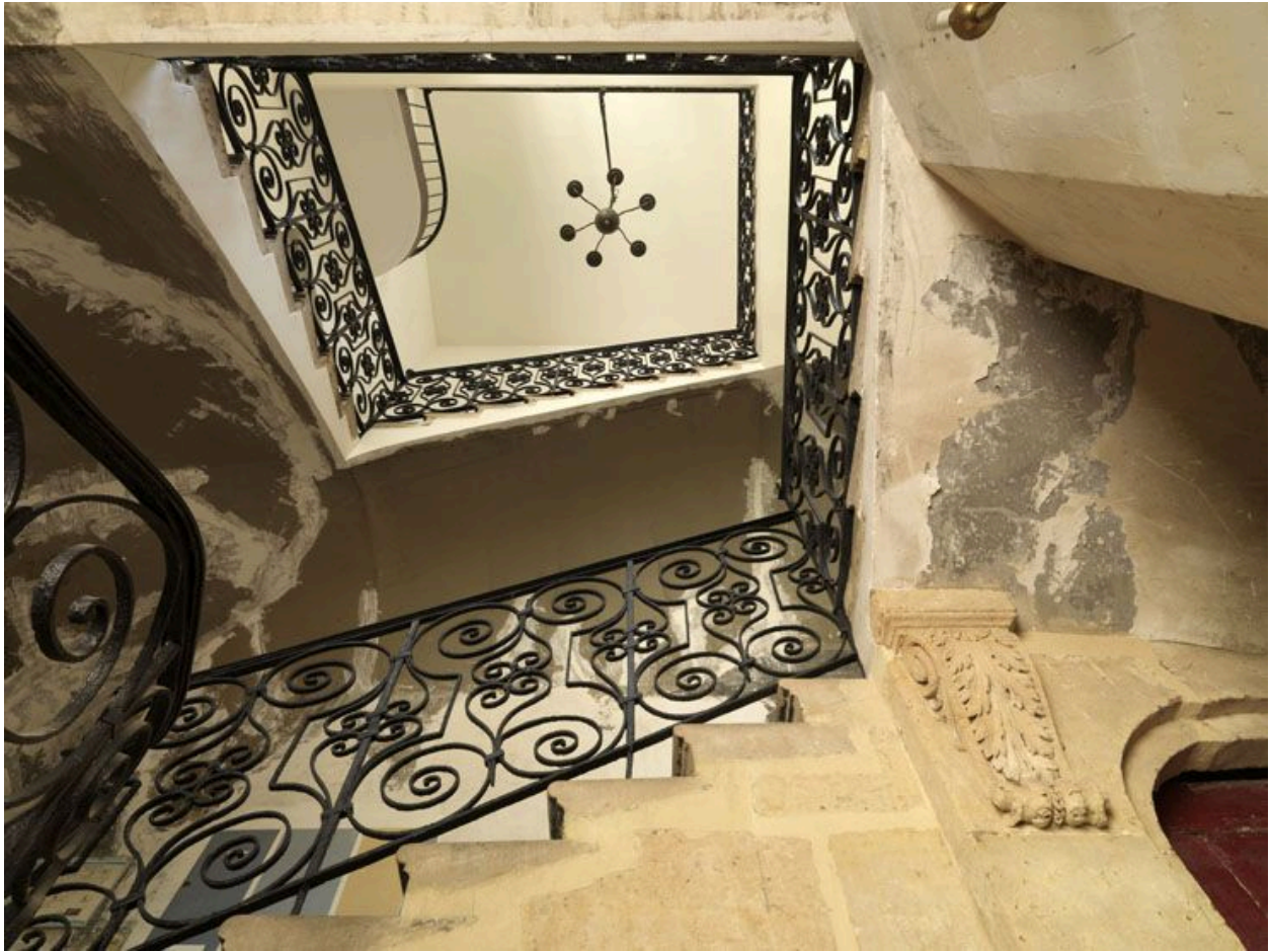
Vue en contre-plongée du vide central.
