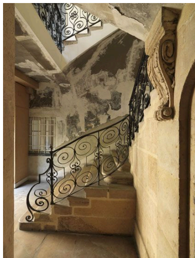
Détail du départ de rampe. Phot. Philippe Ayrault IVR11_20107500402NUC4A
