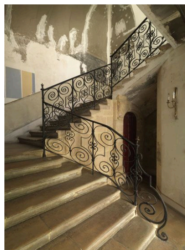
Vue du départ de rampe. Phot. Philippe Ayrault IVR11_20107500401NUC4A
