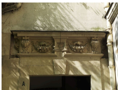
Détail du décor de la porte de l'escalier A. Phot. Philippe Ayrault IVR11_20107500397NUC4A
