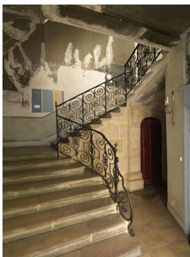
Vue du départ de l'escalier et de sa première volée. Phot. Philippe Ayrault IVR11_20107500400NUC4A
