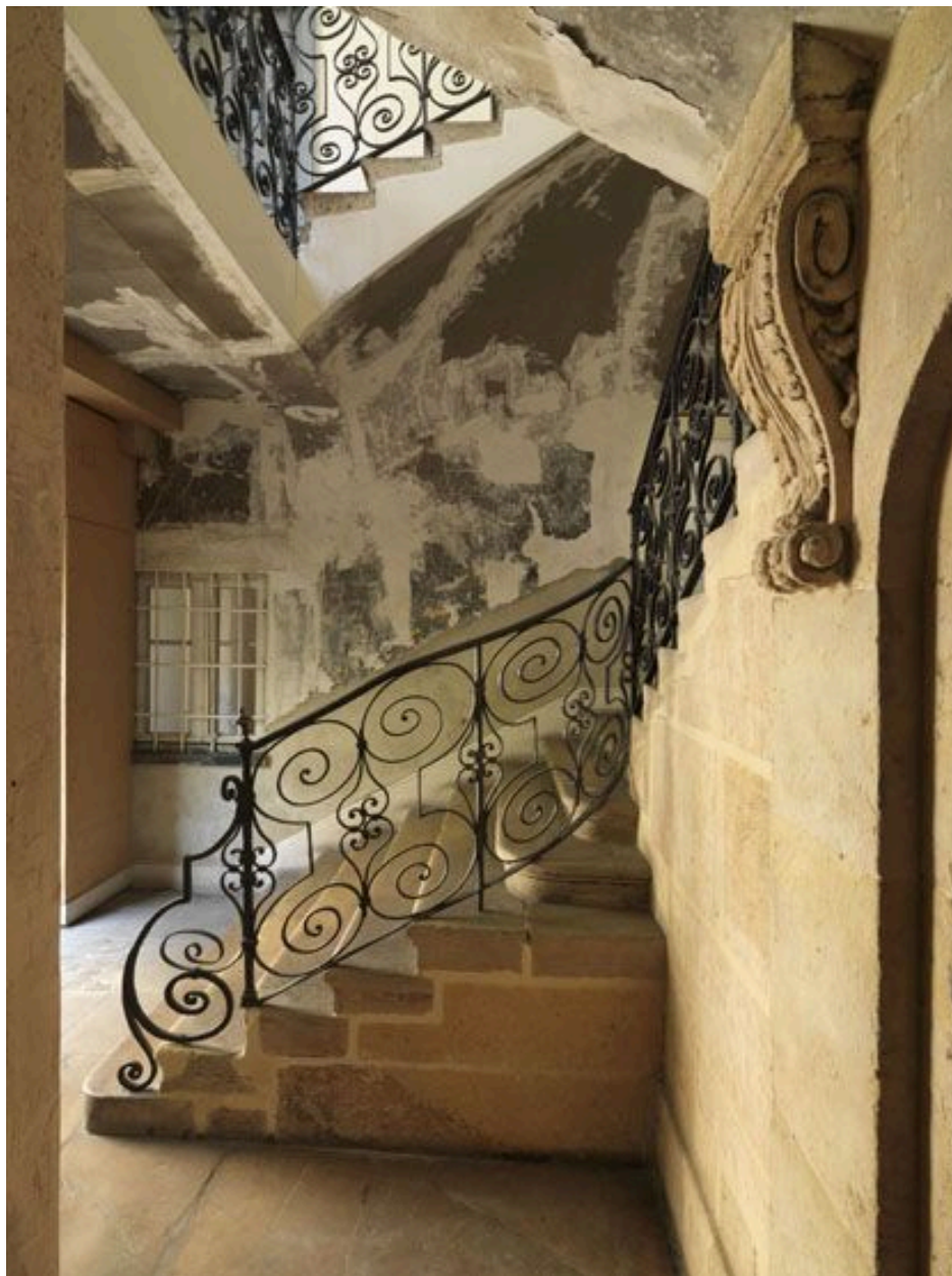
Détail du départ de rampe.
