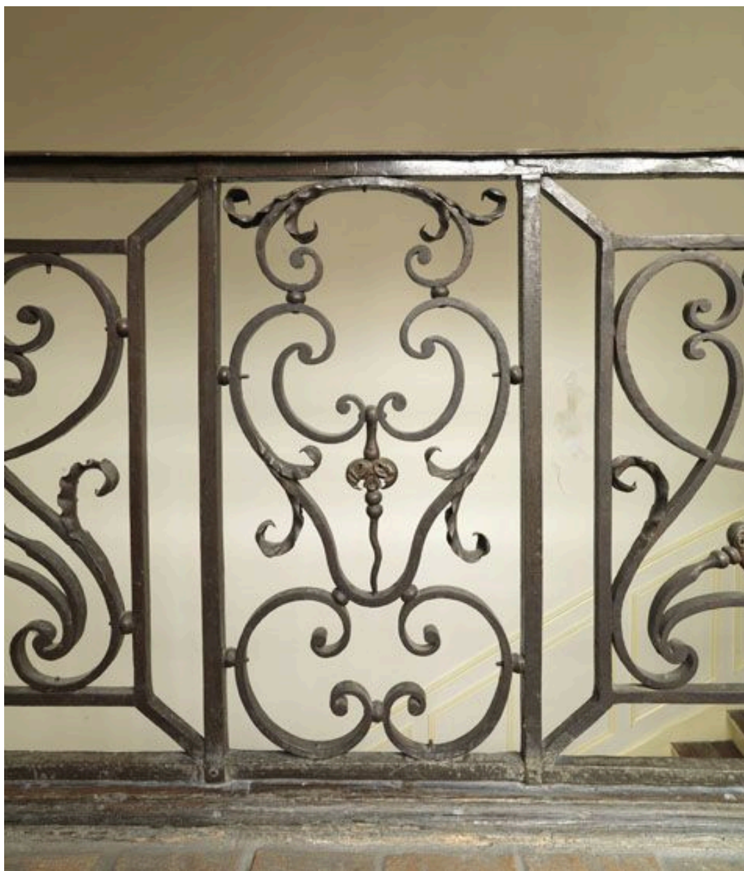
Vue d'un pilastre.
