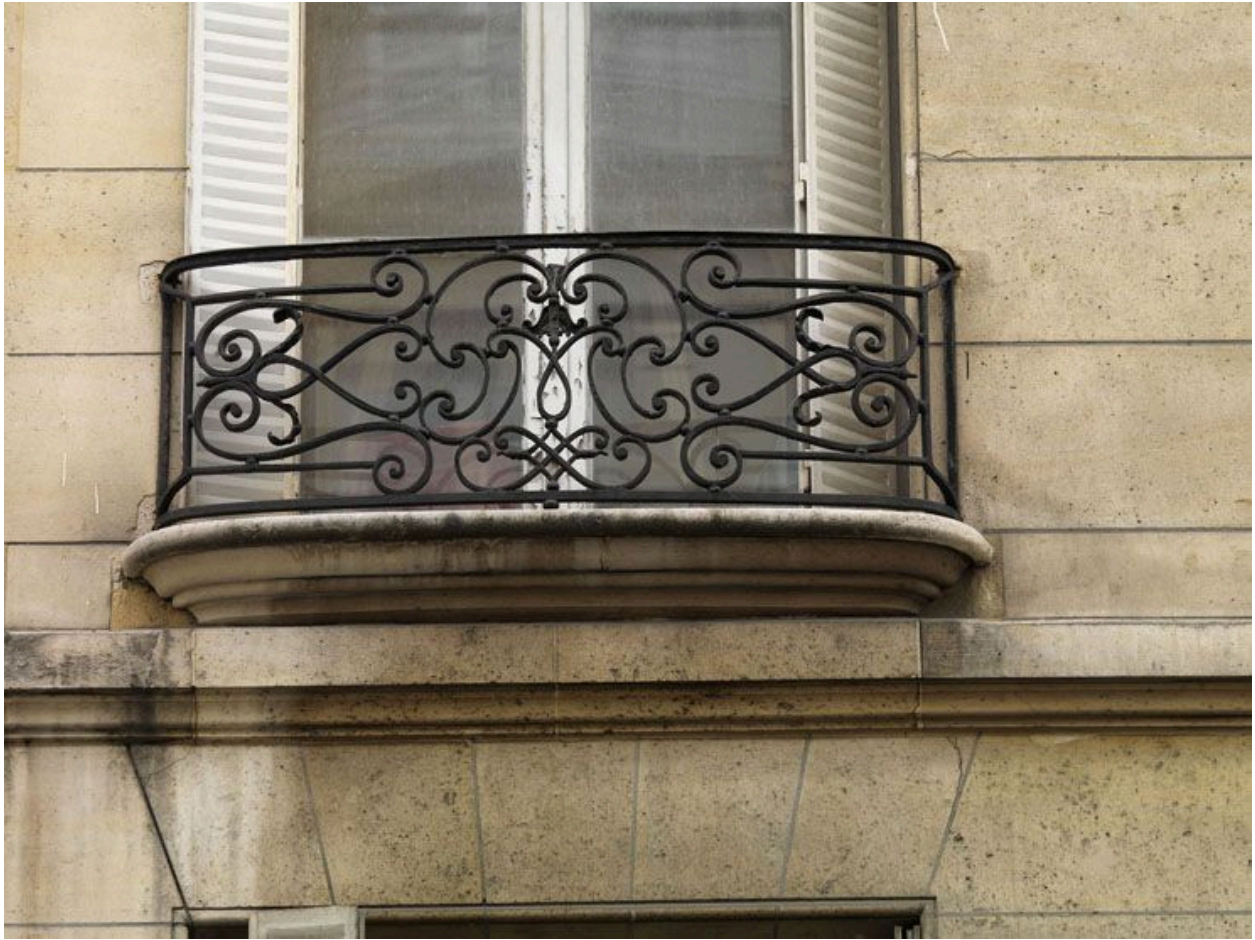
Vue d'un des balconnets.
