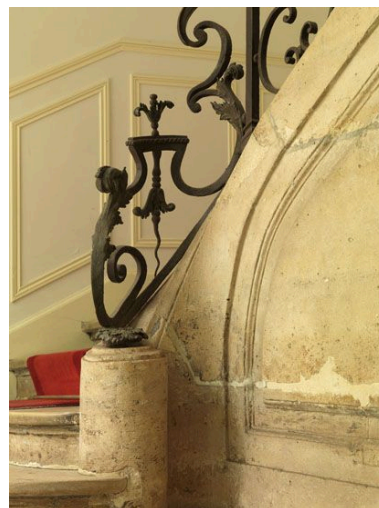
La console de départ, détail. Phot. Laurent Kruszyk IVR11_20097501390NUC4A
