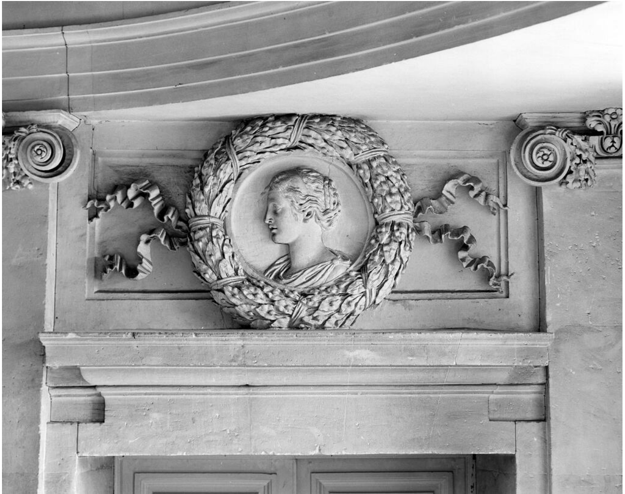
Escalier, palier du 1er étage, bas relief au-dessus de la porte donnant sur les appartements dits de la Reine : buste de femme dans un chapeau de triomphe.
