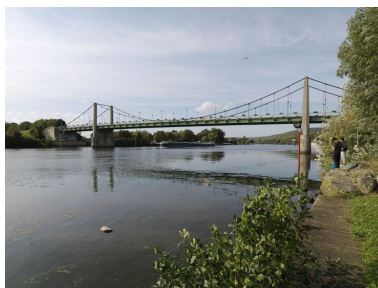
Vue générale de l'ouvrage depuis les quais vers l'aval. On aperçoit sur l'autre rive la culée en béton à laquelle les câbles de retenue sont reliés.
