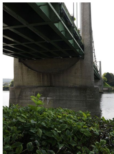
Tablier du pont et ses poutres métalliques vus depuis les quais vers l'amont. On aperçoit la première
