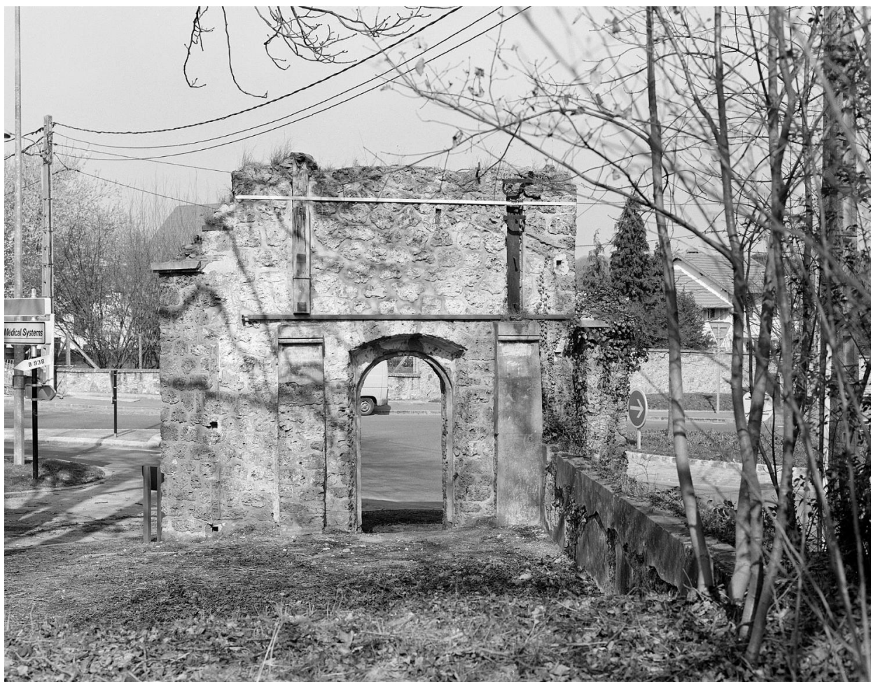
Vue du seul vestige de l'entrée monumentale de l'aéroparc.
