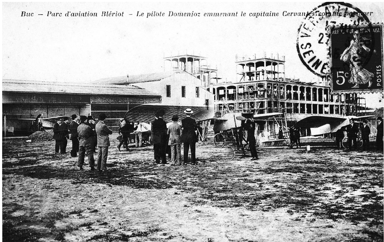
Vue d'ensemble des installations.
