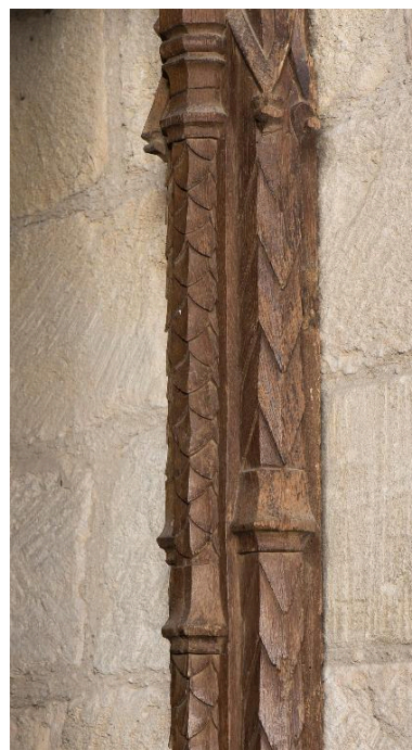
Décor des colonnettes marquant le départ de la clôture.. Phot. Jean-Bernard Barsamian IVR11_20187800459NUC4A
