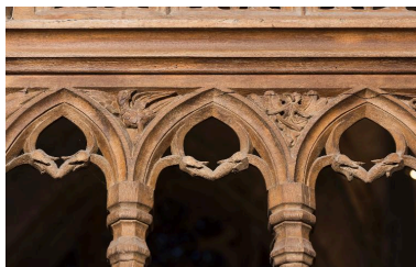
Détail de la partie supérieure des claire-voies : oiseau et feuillages inscrits dans les écoinçons. Phot. Jean-Bernard Barsamian IVR11_20187800439NUC4A
