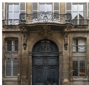
Vue des garde-corps du balcon, des consoles sculptées, de la clé à figure féminine et de la porte cochère de l'entrée de droite.
