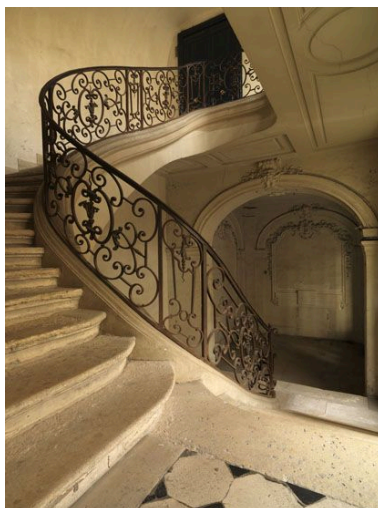
première volée de l'escalier.
