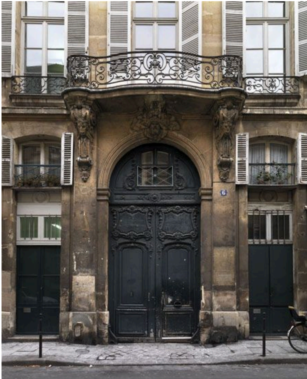
Vue des garde-corps du balcon, des consoles sculptées, de la clé à figure masculine et de la porte cochère de l'entrée de gauche.
