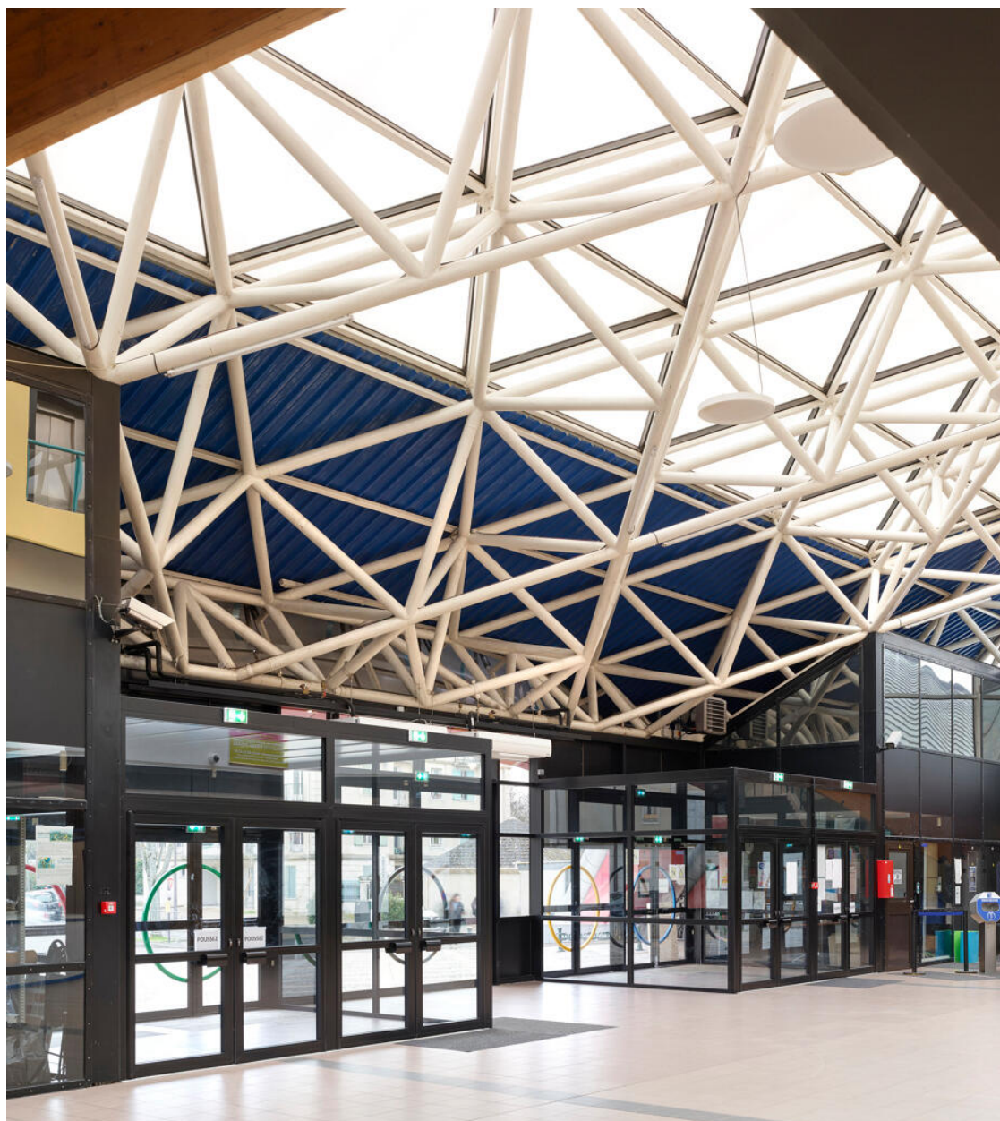
Le palais omnisports de la ville de Thiais. Hall d'entrée.
