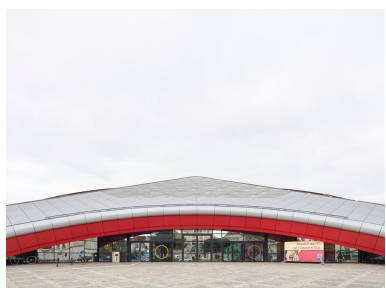
Le palais omnisports de la ville de Thiais. Entrée principale donnant le volume de la salle omnisports. IVR11_20239400001NUC4A
