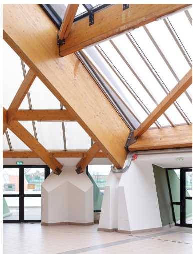
Le palais omnisports de la ville de Thiais. Détail des charpentes. IVR11_20239400027NUC4A
