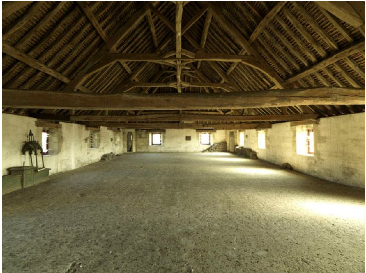
Vue intérieure de l'étage de comble, depuis le sud.
