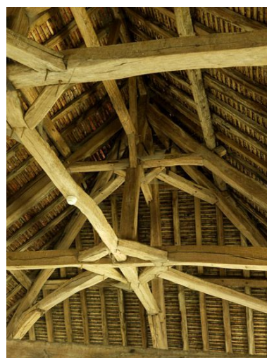
La charpente : détail d'une ferme. Phot. Stéphane Asseline IVR11_20087701000NUC4A
