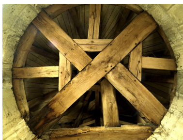
Enrayure d'une tourelle d'angle. Phot. Stéphane Asseline IVR11_20087701005NUC4A
