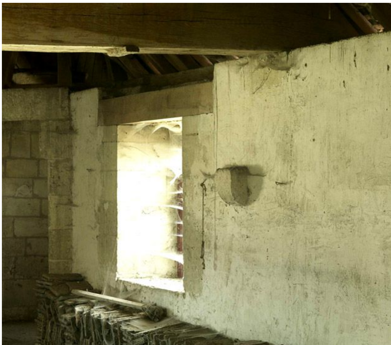
Corbeau dans le mur de l'étage de comble.
