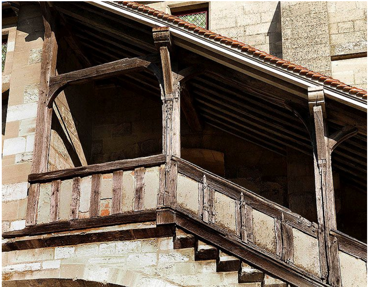
Détail de la galerie en pan de bois de l'escalier extérieur.
