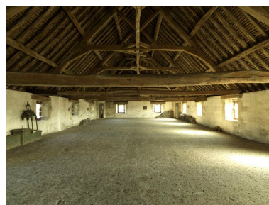
Vue intérieure de l'étage de comble, depuis le sud. Phot. Stéphane Asseline IVR11_20087700997NUC4A
