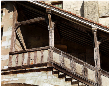
Détail de la galerie en pan de bois de l'escalier extérieur. Phot. Jean-Bernard Vialles IVR11_20137700277NUC4A
