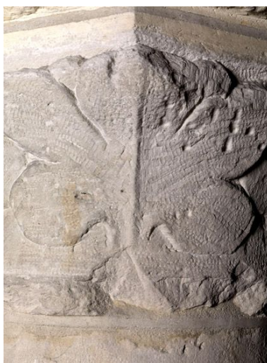
Détail du cliché 20087701023NUC4A: traces de gradine sur le chapiteau sculpté. Phot. Stéphane Asseline IVR11_20087701024NUC4A
