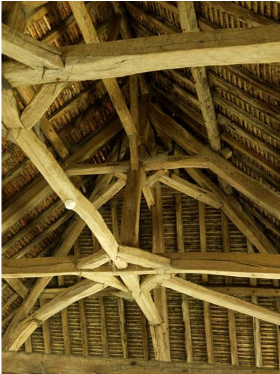
La charpente : détail d'une ferme.
