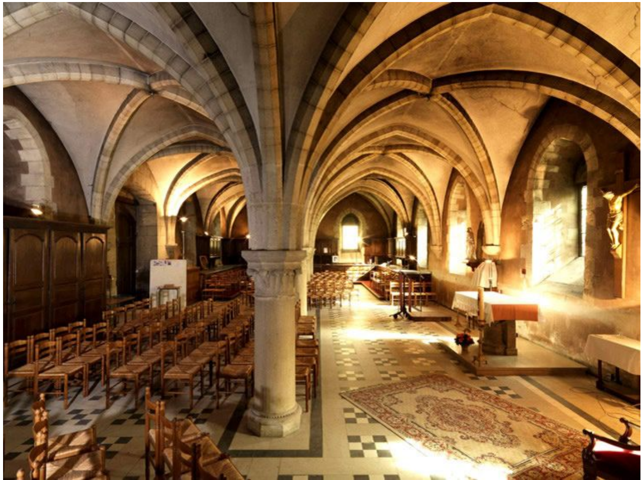
Le rez-de-chaussée : vue intérieure, depuis le sud.
