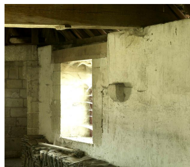
Corbeau dans le mur de l'étage de comble. Phot. Stéphane Asseline IVR11_20087701006NUC4A
