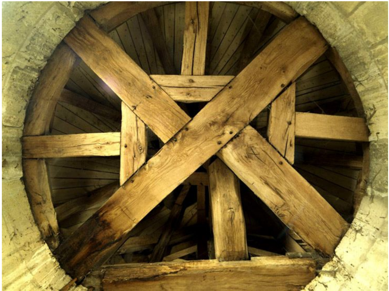
Enrayure d'une tourelle d'angle.
