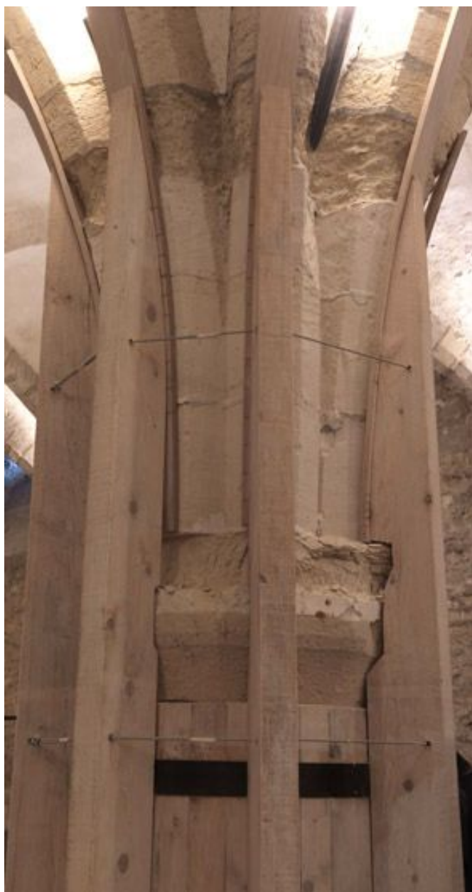
La salle voûtée du sous-sol : chapiteau d'une colonne centrale avec étaieement.
