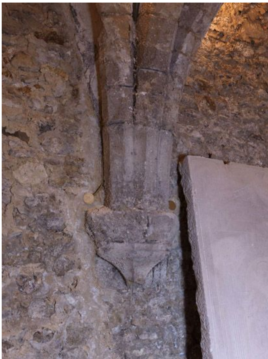
La salle voûtée du sous-sol : détail d'un corbeau.
