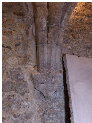
La salle voûtée du sous- sol : détail d'un corbeau. Phot. Stéphane Asseline IVR11_20087701185NUC4A
