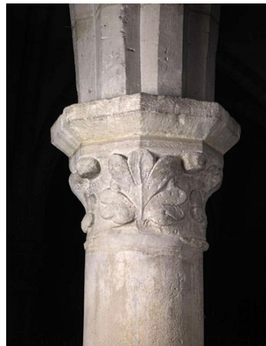
Niveau du rez-de-chaussée (aujourd'hui chapelle d'hiver) : chapiteau à feuilles grasses, sur le premier pilier au sud de l'entrée. Phot. Stéphane Asseline IVR11_20087701022NUC4A
