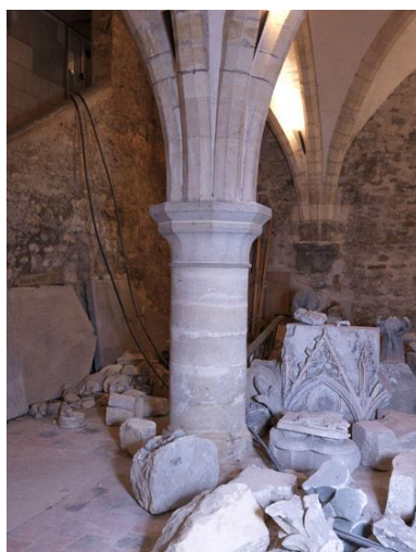
La salle voûtée du sous-sol : vue d'une colonne centrale. Phot. Stéphane Asseline IVR11_20087701183NUC4A
