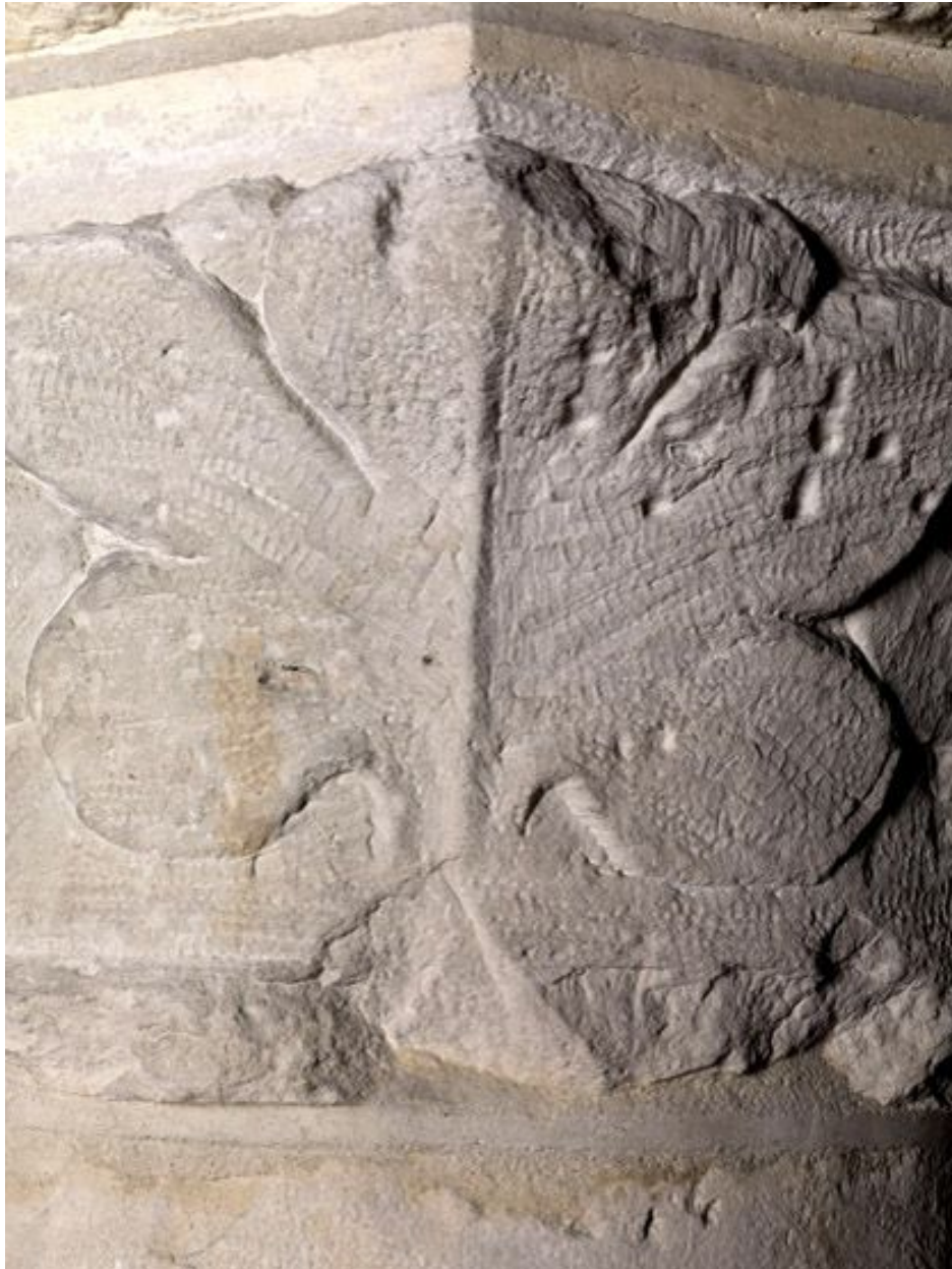
Détail du cliché 20087701023NUC4A: traces de gradine sur le chapiteau sculpté.
