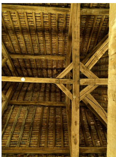
La charpente : vue d'une ferme. Phot. Stéphane Asseline IVR11_20087701002NUC4A
