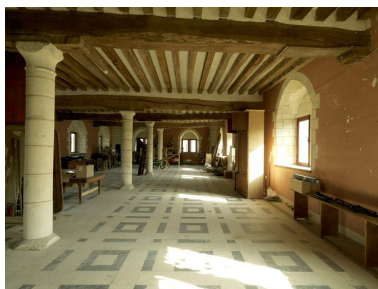
Le premier étage : vue de la partie orientale. Phot. Stéphane Asseline IVR11_20087700990NUC4A
