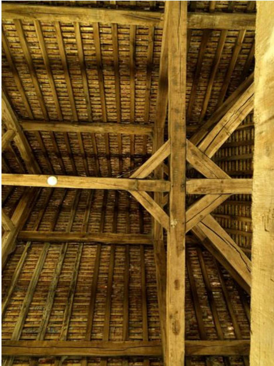
La charpente : vue d'une ferme.
