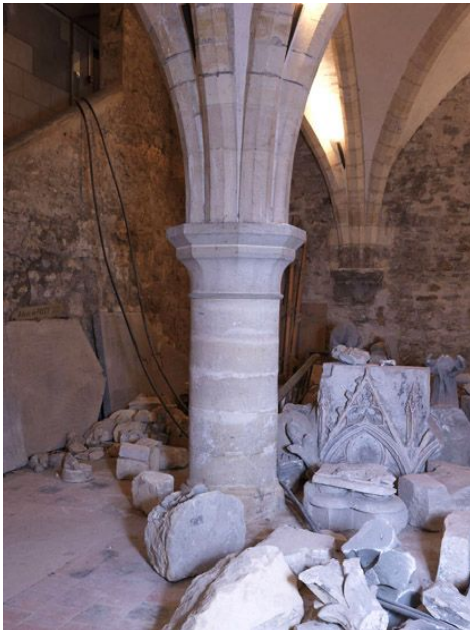
La salle voûtée du sous-sol : vue d'une colonne centrale.
