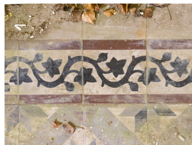
Maison d'Octave Allaire, frise ornementale à rinceau végétal ornant le sol des pièces du rez- de-chaussée en carreaux de ciment Phot. Asseline Stéphane IVR11_20257800229NUC4A
