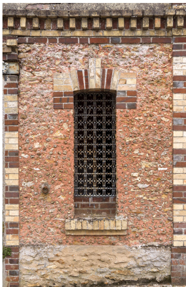
Maison d'Octave Allaire, fenêtre du garage Phot. Asseline Stéphane IVR11_20257800214NUC4A
