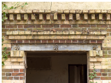
Maison d'Octave Allaire, couvrement d'une fenêtre : linteau métallique à fleurons, corniche et denticules en brique. Phot. Asseline Stéphane IVR11_20257800209NUC4A
