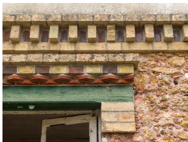
Maison d'Octave Allaire, détail de la modénature, alternant les mises en œuvre de la brique Phot. Asseline Stéphane IVR11_20257800204NUC4A
