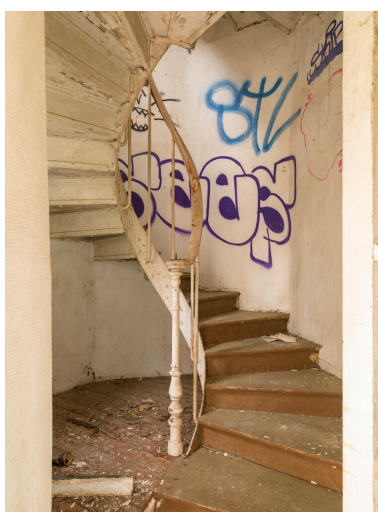
Maison d'Octave Allaire, départ de l'escalier reliant le premier et le second étage Phot. Asseline Stéphane IVR11_20257800225NUC4A
