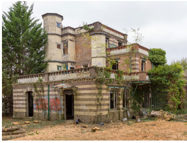
Maison d'Octave Allaire, vue générale depuis le jardin Phot. Asseline Stéphane IVR11_20257800193NUC4A
