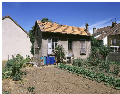
Vue d'ensemble du cabanon et de son potager. Phot. Philippe Ayrault IVR11_20019100268XA
