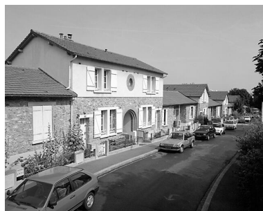
Vue d'ensemble. Maisons Phot. Décamps Christian IVR11_19979400694X
