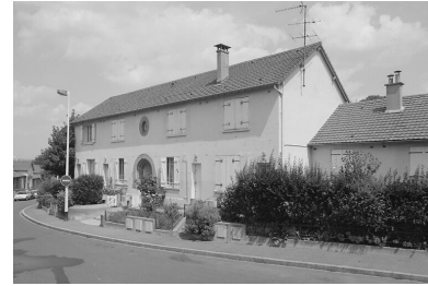
Vue d'ensemble. Maisons Phot. Décamps Christian IVR11_19979400695X
