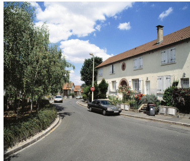
Vue de la rue Maxime-Bacquet. Cité jardin dite de l'Aqueduc Phot. Asseline Stéphane IVR11_20029400096XA
