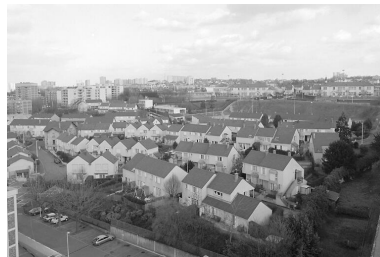
Vue partielle de la cité jardin prise depuis le tablier du pont aqueduc de la Vanne. Cité jardin dite de l'Aqueduc Phot. Décamps Christian IVR11_19979400256X
