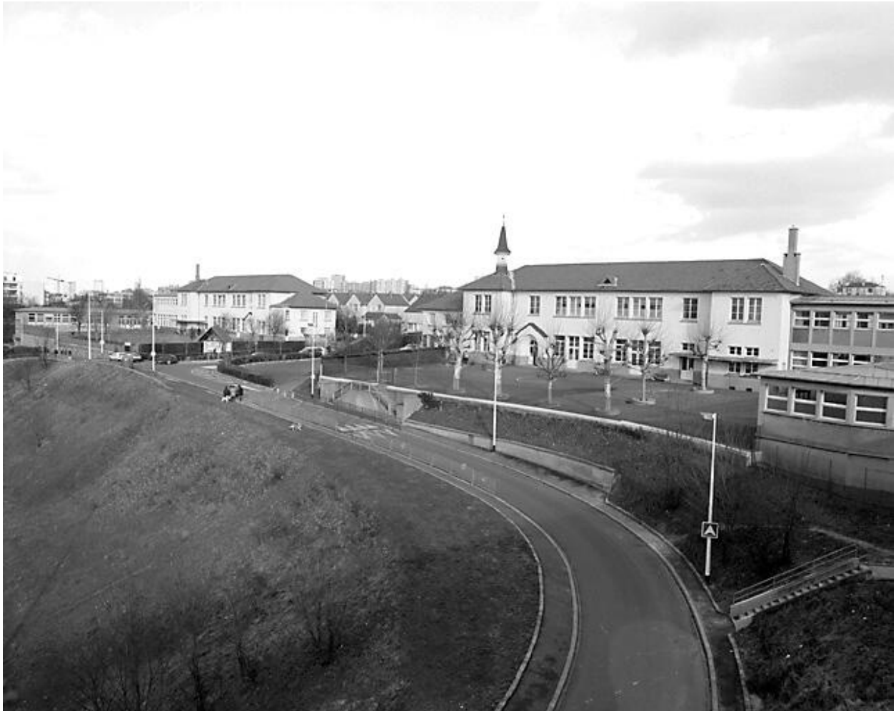
Vue d'ensemble prise depuis le tablier du pont aqueduc de la Vanne. Au premier plan, l'école des garçons. Cité jardin dite de l'Aqueduc
