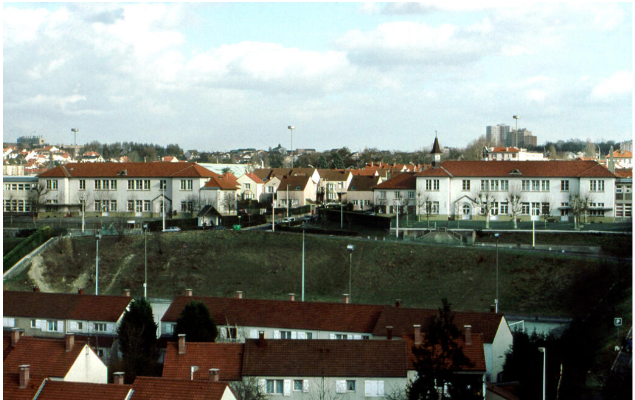
Vue d'ensemble prise depuis le tablier du pont-aqueduc de la Vanne. Cité jardin dite de l'Aqueduc
