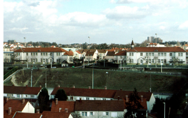
Vue d'ensemble prise depuis le tablier du pont-aqueduc de la Vanne. Cité jardin dite de l'Aqueduc Phot. Décamps Christian IVR11_19979400252ZA
