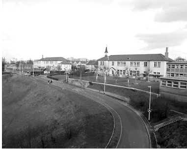
Vue d'ensemble prise depuis le tablier du pont aqueduc de la Vanne. Au premier plan, l'école des garçons. Cité jardin dite de l'Aqueduc Phot. Décamps Christian IVR11_19979400250X
