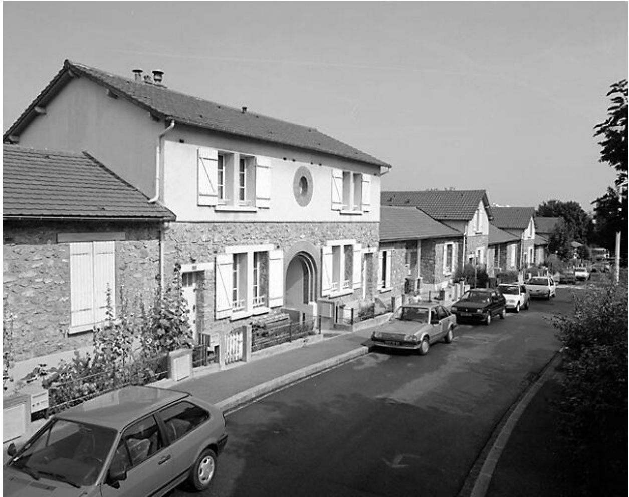
Vue d'ensemble. Maisons
