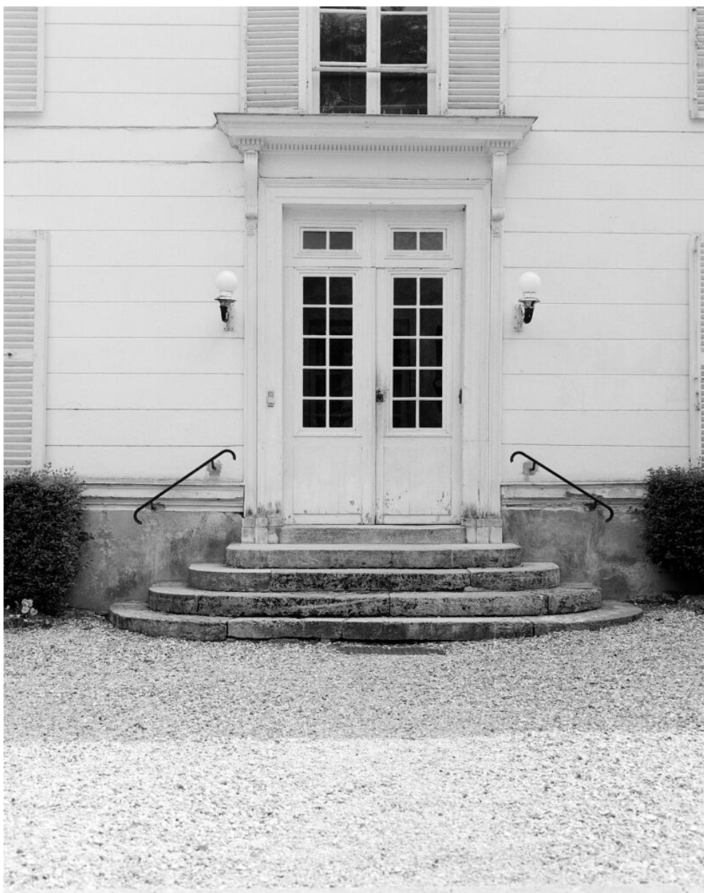
Détail de la façade nord : porte et perron.
