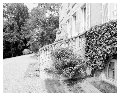
Profil de l'escalier de la façade ouest. Phot. Vialles Jean-Bernard IVR11_19917800279X
