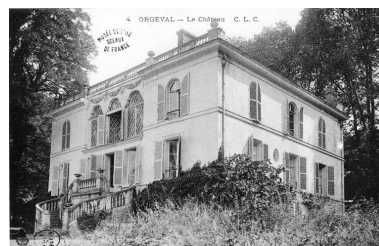
Vue d'ensemble. Carte postale (domaine départemental de Sceaux). IVR11_19917800031XB
