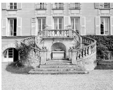
Escalier de la façade ouest. Phot. Vialles Jean-Bernard IVR11_19917800278X
