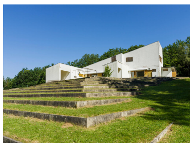
Côté sud, les terrasses des chambres ouvrent sur la pente douce conduisant à la piscine.
