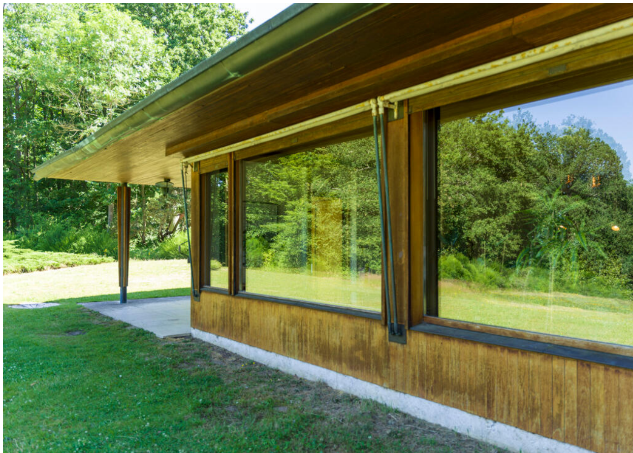
Les baies du salon.
