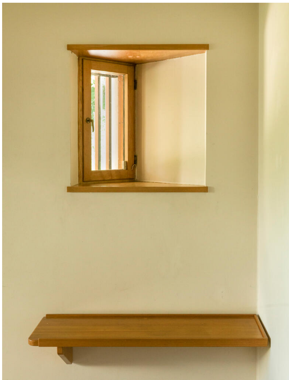
Détail du fenestron en biais ouvrant sur la façade d'entrée.
