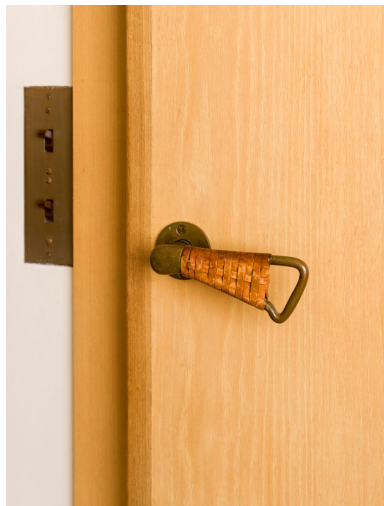
Détail d'une poignée de porte en bronze recouverte de lamelles de cuir naturel pour une meilleure préhension. Phot. Asseline Stéphane IVR11_20247800387NUC4A
