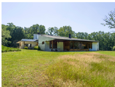
L'angle nord-ouest. Sur la droite, la longue baie du salon, qui ouvre sur la vue. A gauche, la façade d'entrée.
