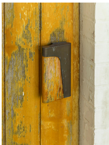
Détail de la poignée de porte, en bois et bronze. Phot. Asseline Stéphane IVR11_20247800339NUC4A
