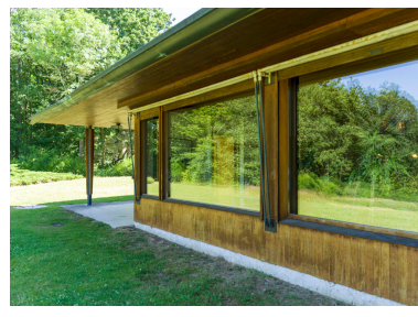
Les baies du salon.
