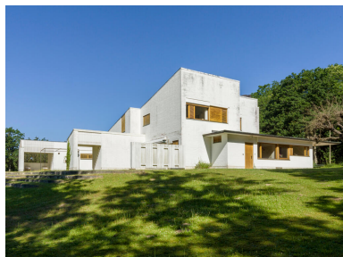
Angle sud-est. A droite la partie réservé aux services, à gauche les terrasses des chambres de maître.
