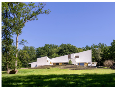
Vue générale de la façade sud et de ses petites terrasses couvertes. Les emmarchements épousent la pente et suivent ses irrégularités.
