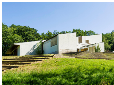
Angle sud-ouest. Jeux de clairevoies anti-éblouissement sur les façades.
