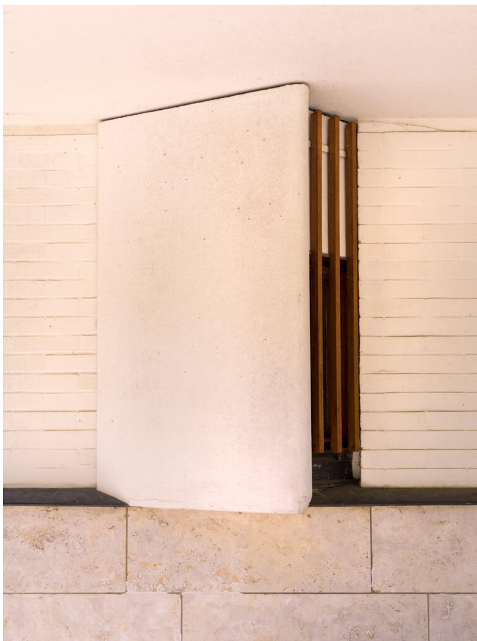
En façade nord, petite fenêtre à clairevoie de la salle à manger.
