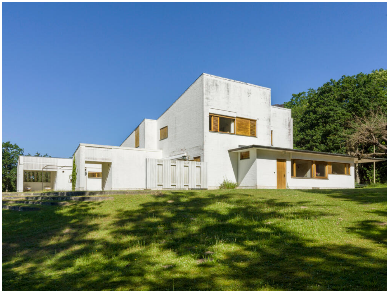
Angle sud-est. A droite la partie réservé aux services, à gauche les terrasses des chambres de maître.
