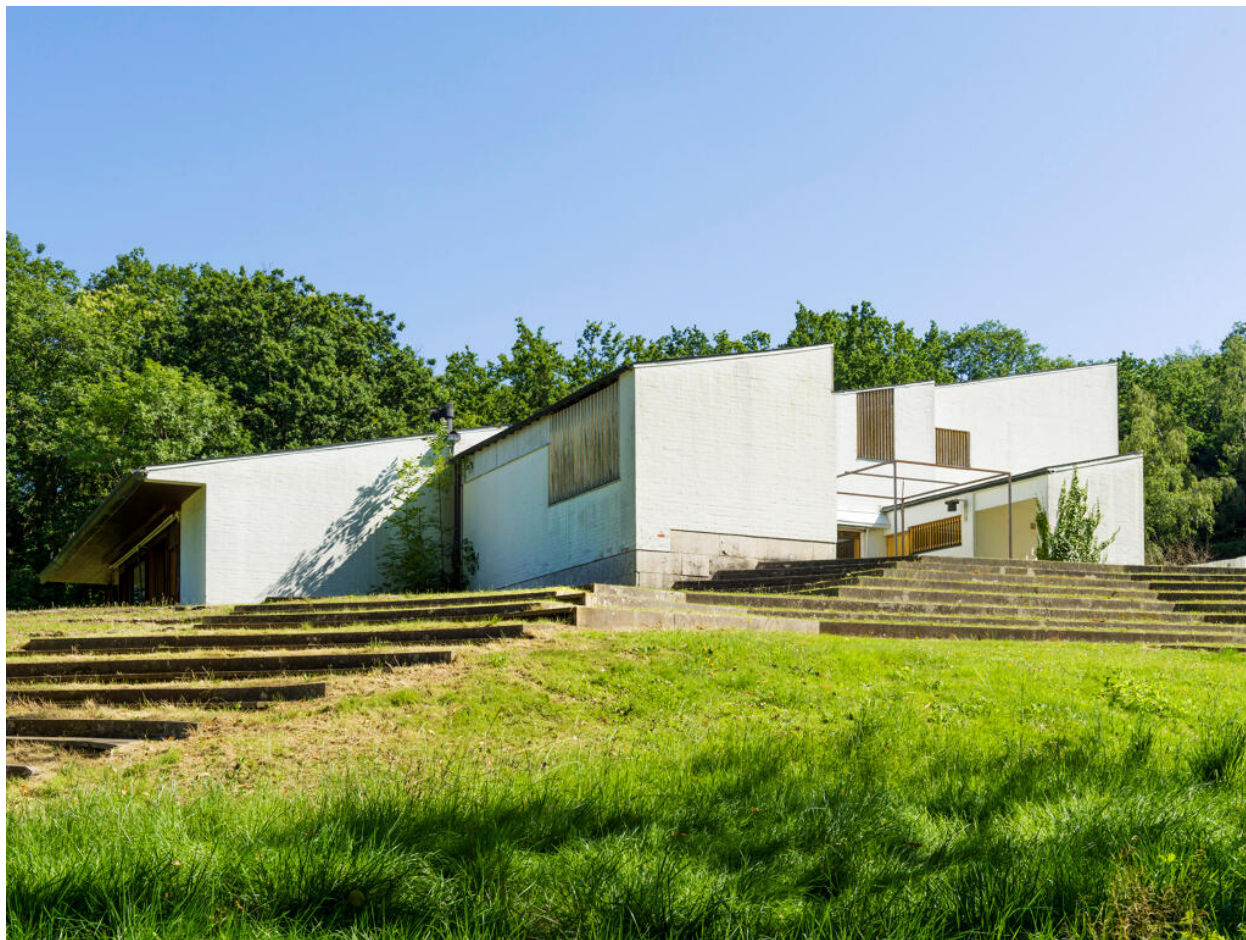
Angle sud-ouest. Jeux de clairevoies anti-éblouissement sur le façades.
